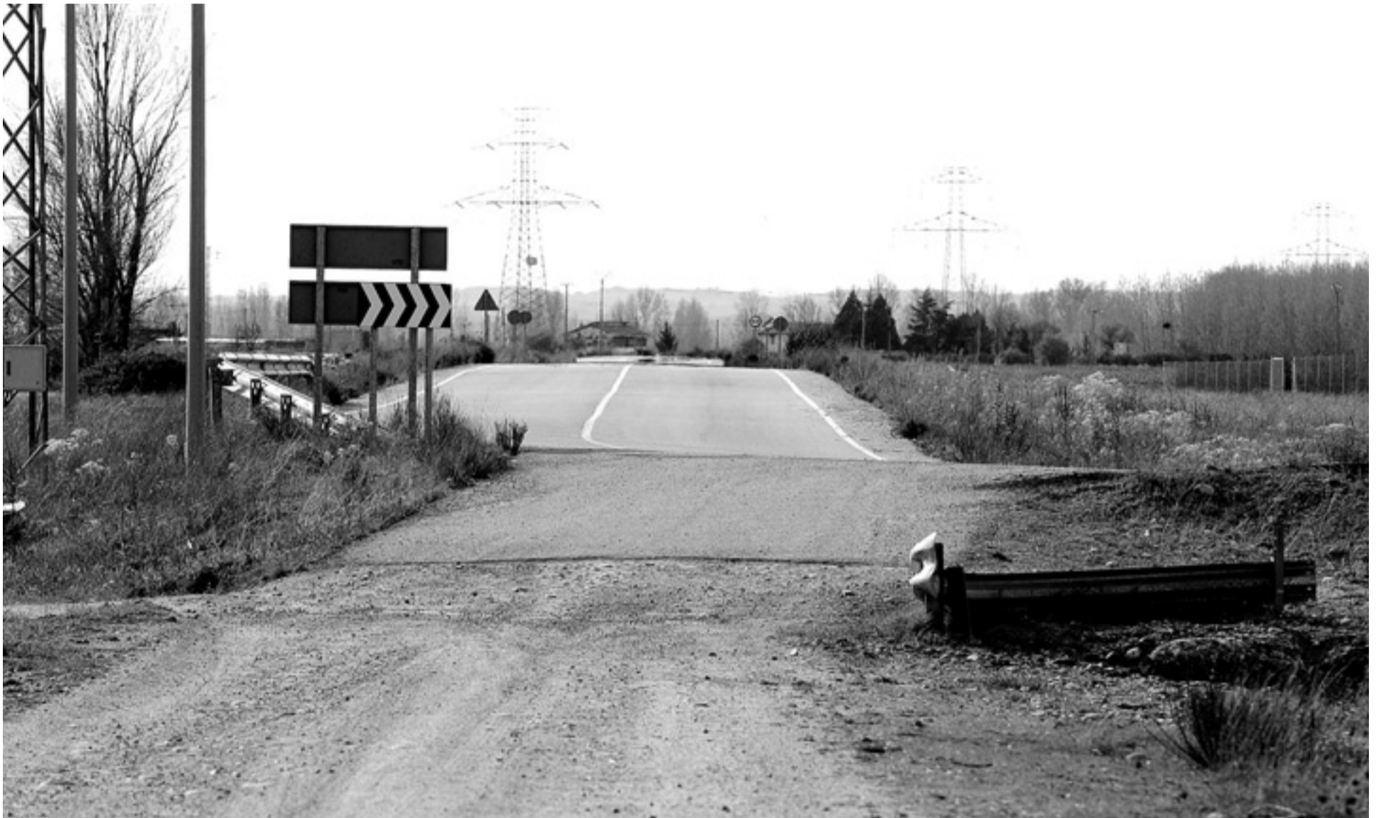
La histórica Vía Trajana a su paso por Mansilla, donde ha sufrido todo tipo de agresiones: concentración parcelaria, postes de alta tensión y hasta la carretera de la cárcel. MAURICIO PEÑA
