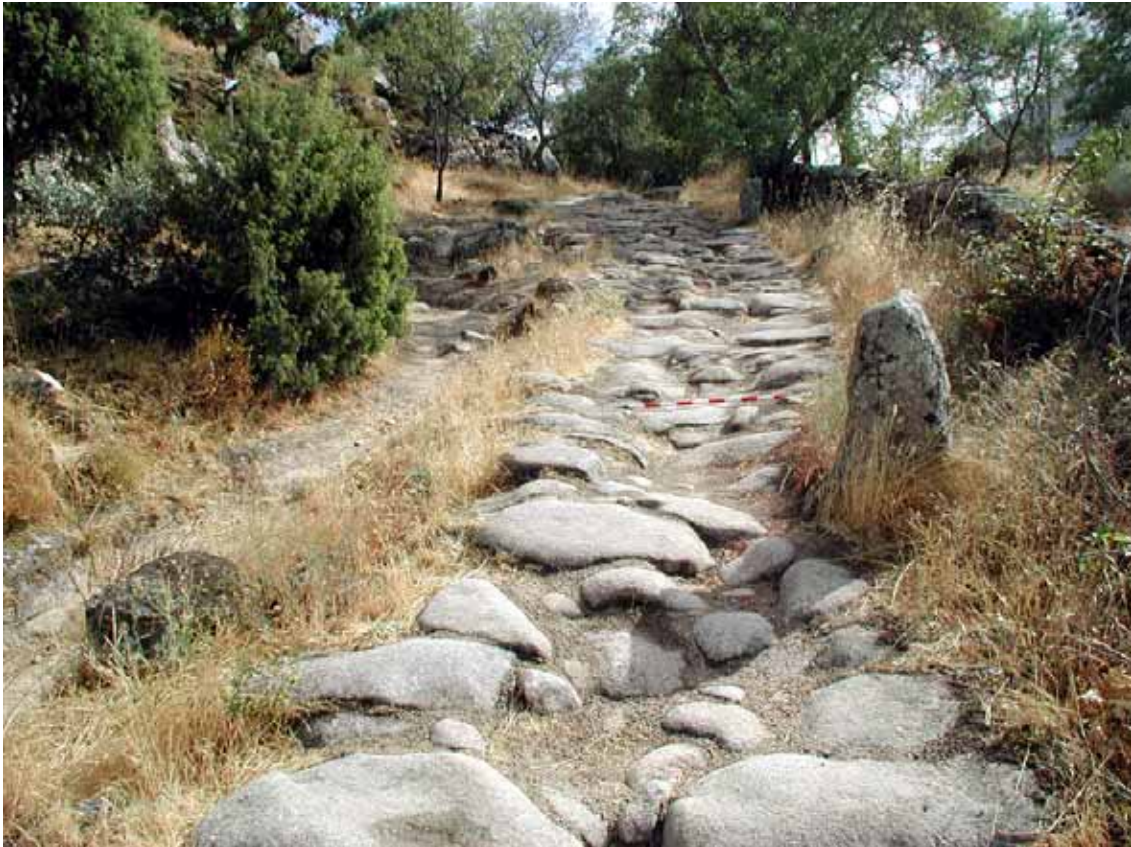
Camino de mulas en El Escorial, conocido como de la Machota, considerado como arquetipo romano durante muchos años. Presenta elevadas pendientes y un enlosado desgastado por la pisada de los mulos.
