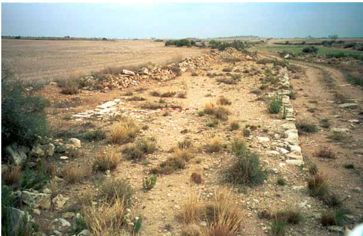
Márgenes y piedra de cimentación del llamado Camino del Diablo, en Huesca. Se retiraron las capas de rodadura cuyo material puede verse amontonado en el costado izquierdo de la foto.
