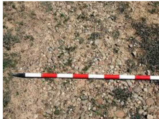
Detalle de la capa de rodadura en la vía de Clunia .
