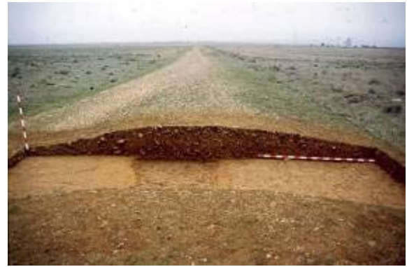
Material granular en la sección de la vía A17, Item a Bracara Asturicam , en Valderrey (León). Foto de Jesús C. Misiego (STRATO, 1996).
