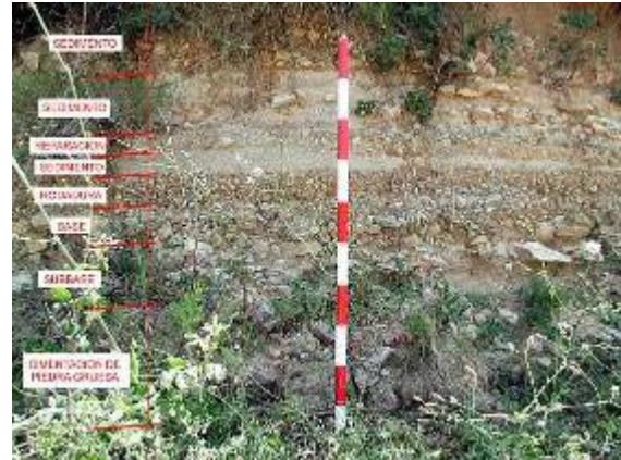
Sección de la Via Domitia en la que se aprecian las capas del firme romano, sedimentos y reparaciones, en Florensac.
