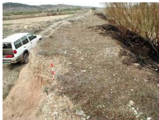
Vía romana seccionada en La Rioja mostrando todo el paquete de firme de zahorras.
