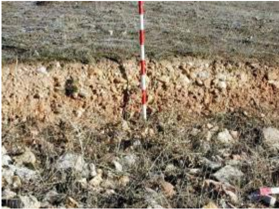
Detalle de la capa de rodadura de canto rodado en la Vía de la Plata.
