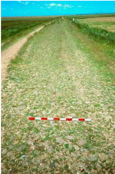
Aspecto del material de la capa de rodadura en la Vía de Italia a Hispania en León.
