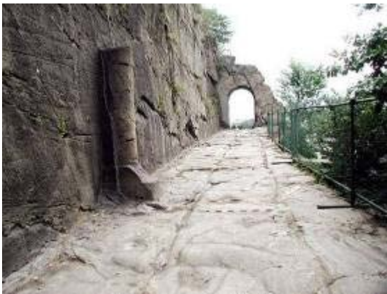
Entalle excavado a media ladera para el paso de la vía romana en Donnas, Valle de Aosta-Italia
