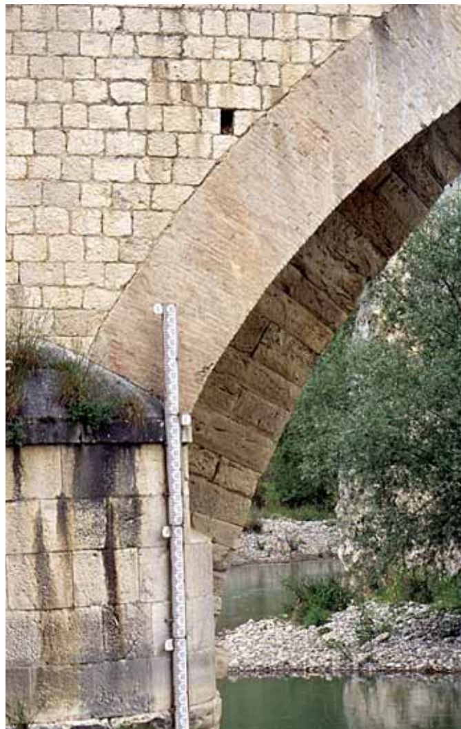
Fig. 22. Vista parcial de la boquilla aguas arriba del puente de San Cono (Italia).
