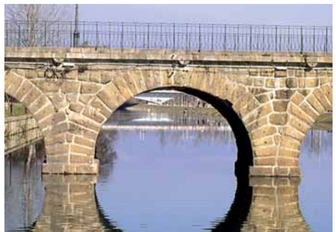
Fig. 18. Dovelas de mayor tamaño en la parte baja del puente de Chaves (Portugal).
