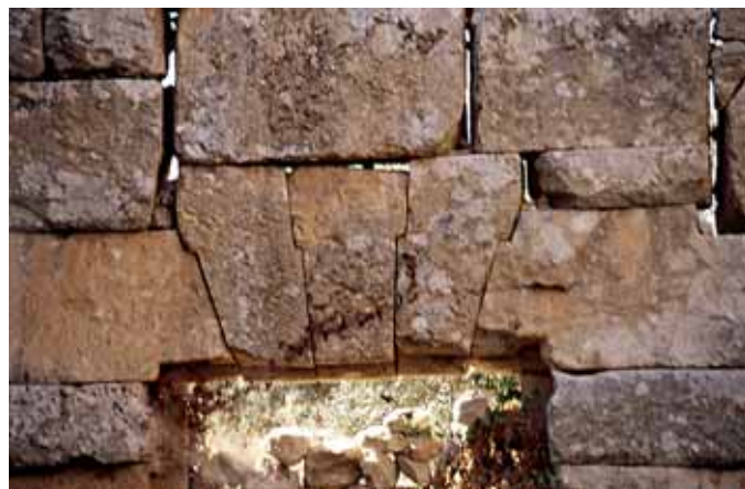
Fig. 20. Dintel adovelado del Santuario de San Simon (Siria)'. '
