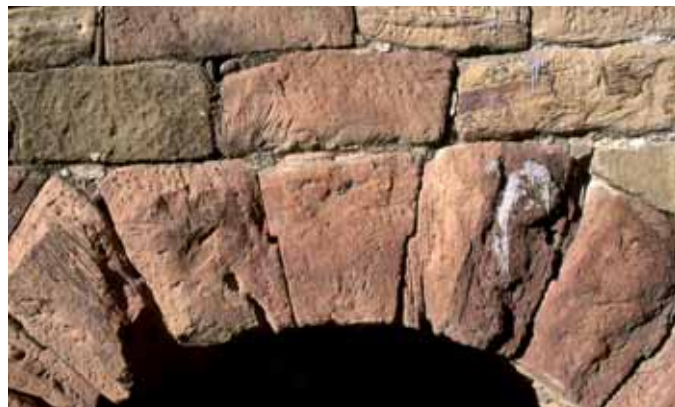
Fig. 21. Arco con dovelas engatilladas del puente de Villa del Río (Córdoba).
