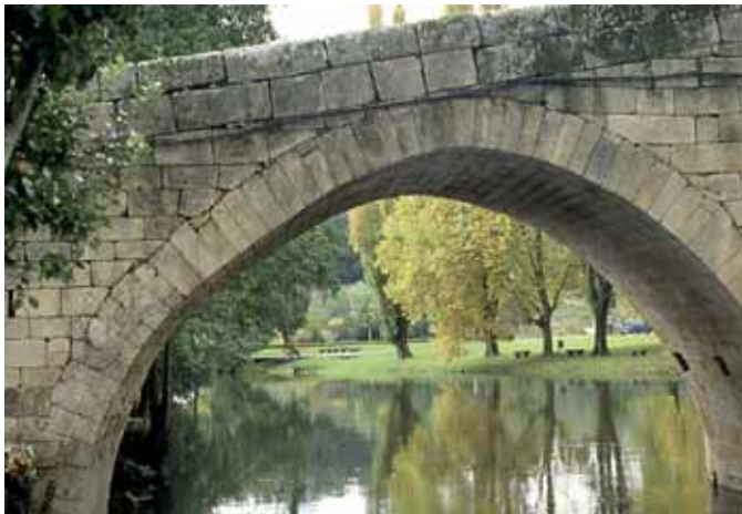
Fig. 5. Arco izquierdo del puente de Vilanova en Allariz (Ourense).
