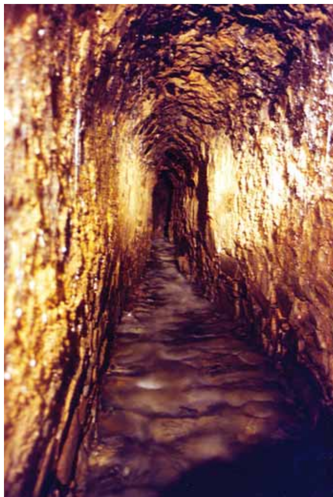
Fig. 3. Tramo de cloaca abovedada prolongación de la que discurre bajo el cardo maximus hacia el sur.
