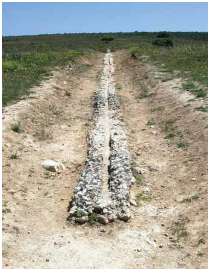
Fig. 17. Canalización de hormigón para la entrada de agua a Segóbriga (Cuenca).
