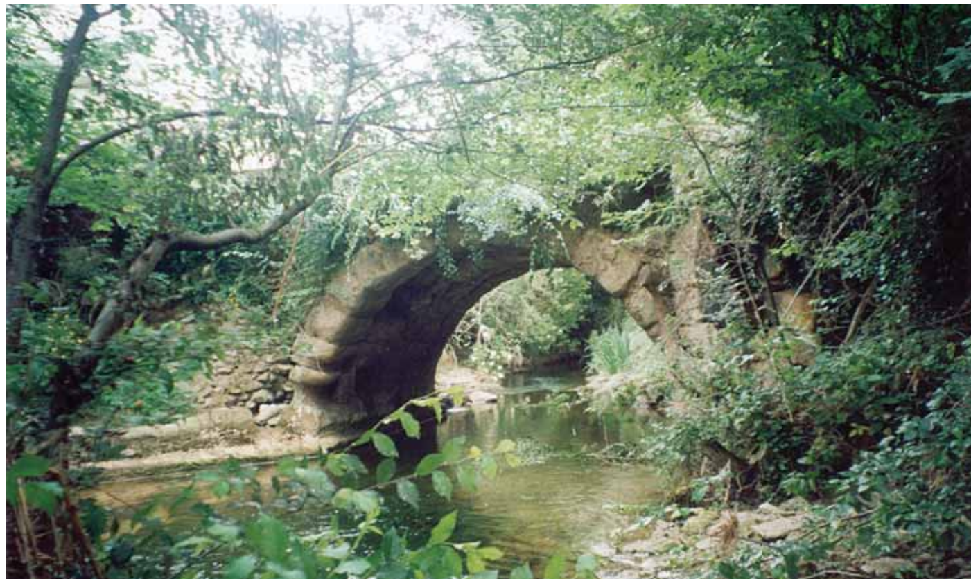
Fig. 13. Puente Romano de Cerezo (Burgos).
