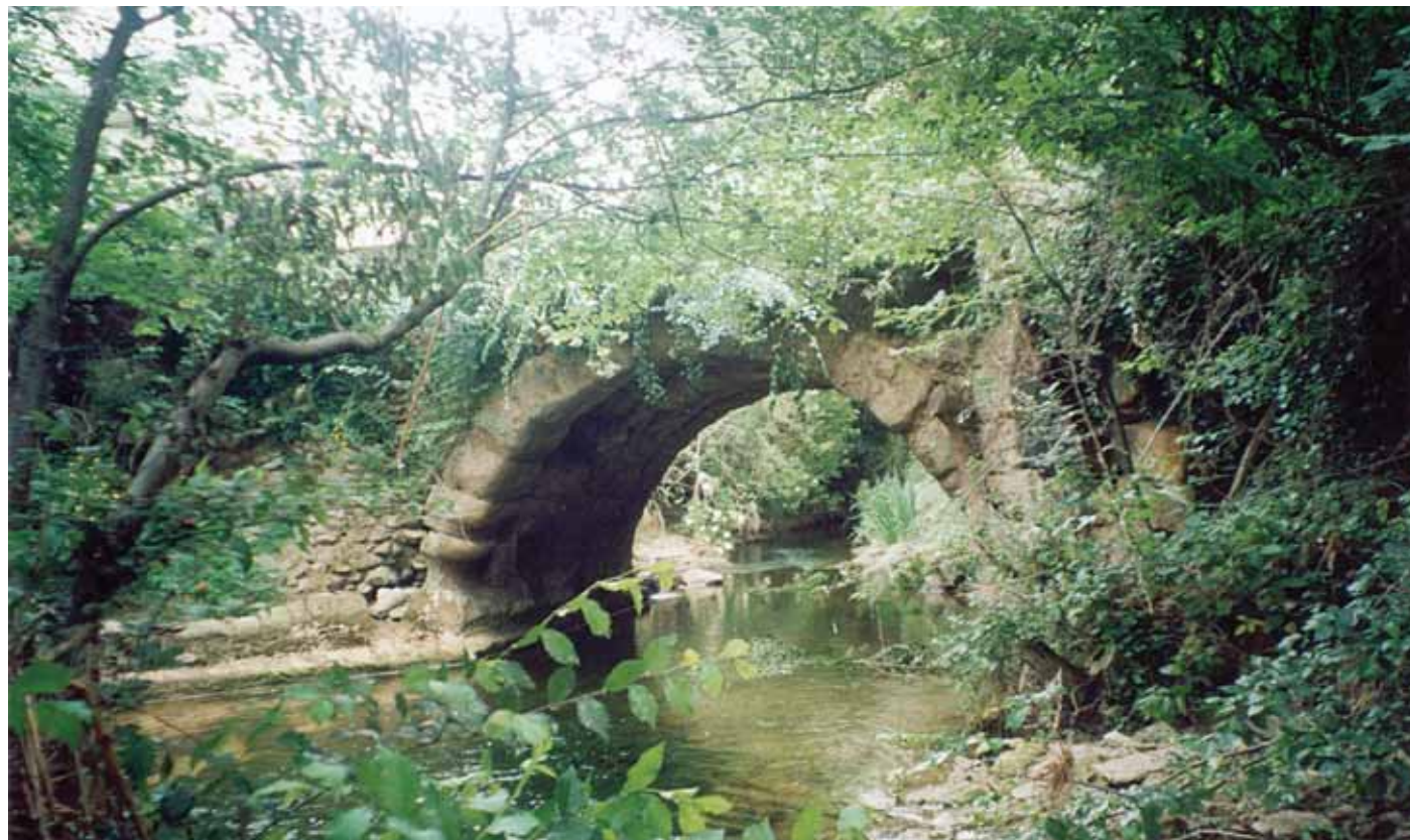
Fig. 13. Puente Romano de Cerezo (Burgos).
