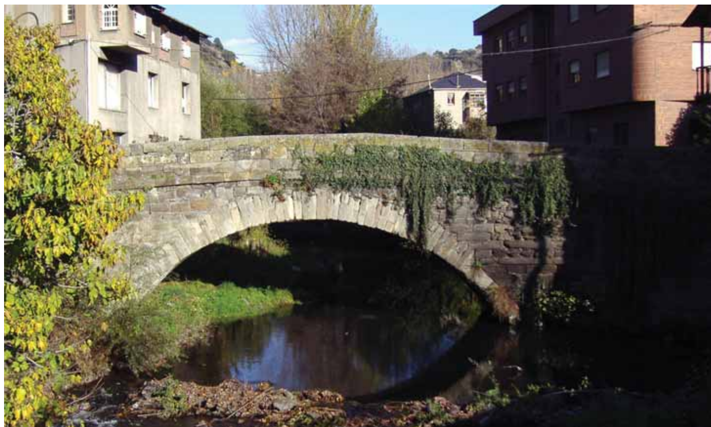
Fig.11. Puente de Torre del Bierzo.
