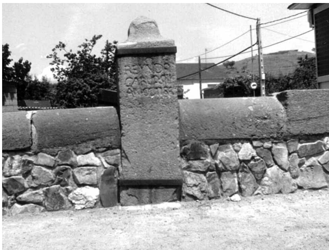
Fig. 8. Alcantarilla de Mojasacos (Bembibre)
