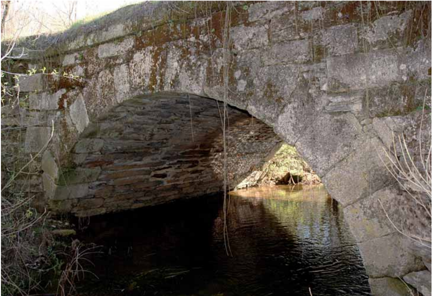
Fig. 15. Puente de Cobrana.
