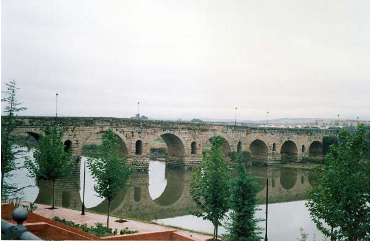
Figura 12: Puente romano de Mérida
