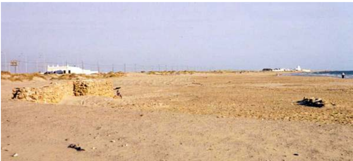
Figura 5: Via Heraclea entre Gadir y el Templo de Heracles, limitada por dos muretes de hormigón para evitar el transporte eólico.
