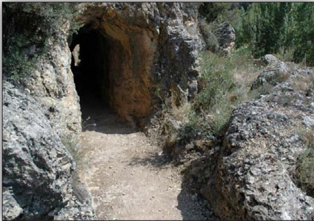
Canal primigenio en el exterior de la actual galería en la zona de los Espejos 2. Después de haber sido variado por el actual este tramo de canal pudo ser utilizado como aliviadero.
