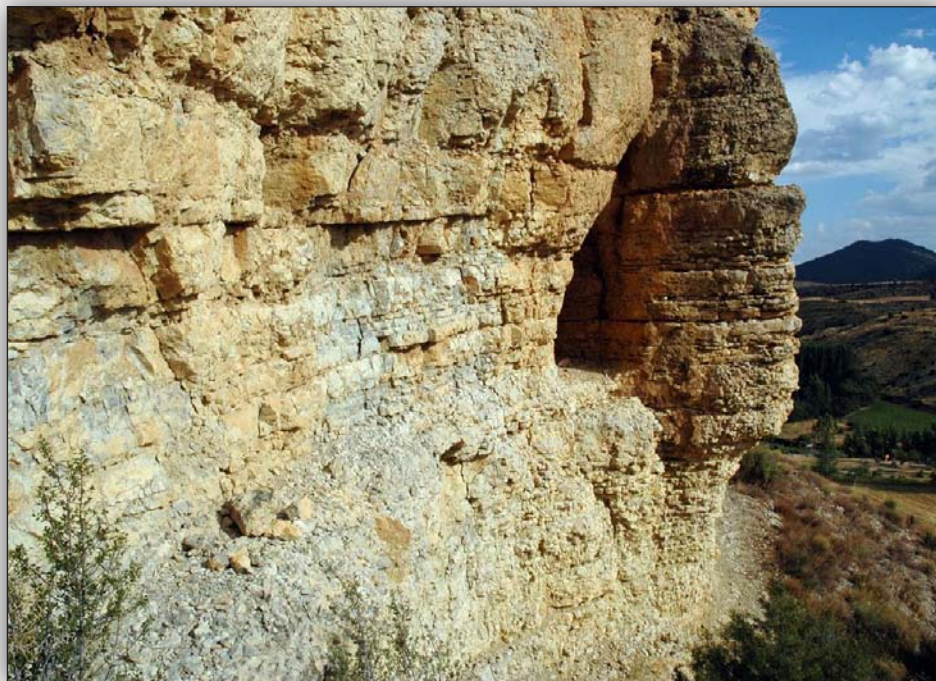
Tramo de canal desaparecido por los desprendimientos en la roca poco homogénea y escasamente compacta, en los escarpes del Azud de Gea.
