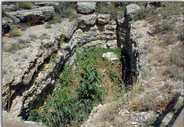
Boca de grandes proporciones de uno de los pozos de registro más altos del túnel largo.
