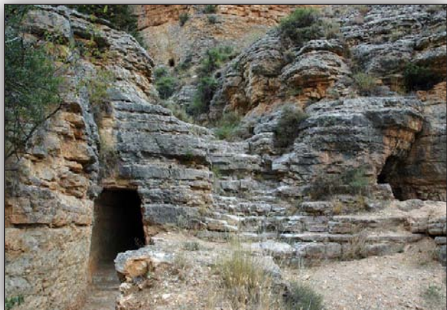
Cruce del acueducto con la escorrentía del barranco de los Burros. El túnel excavado impide cualquier interferencia entre ambas aguas.
