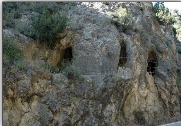
Ventana aliviadero en la zona de los Espejos. La ventana central apenas tiene veinte centímetros de resguardo. Tramo variado en vida del acueducto. Se observa en el exterior el repicado del canal primigenio.
