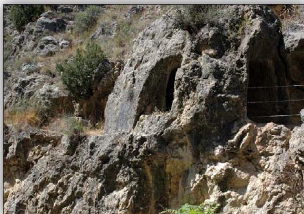
Entalle exterior a la galería del acueducto en la zona de los Espejos 1. Se aprecian la pared y la solera de la primigenia galería destruida y variada por la actual.
