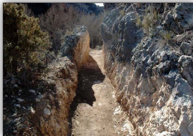
Canal aguas abajo del túnel de la carretera de Gea a Albarracín.
