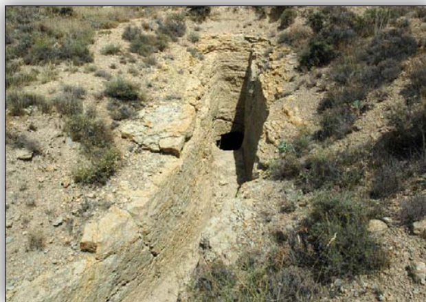
Callejón de evacuación de tierras para la excavación, en el pozo de registro de la inflexión ortogonal del túnel en su tramo inicial.
