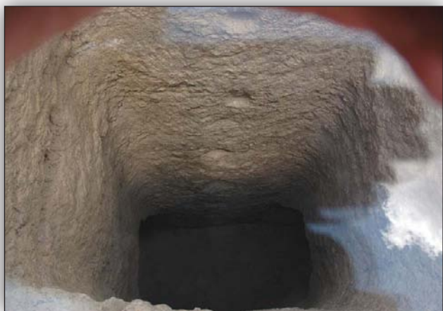
Pozo de registro en el inicio del túnel largo. Se observan los entalles para el apoyo de las maderas de escala.
