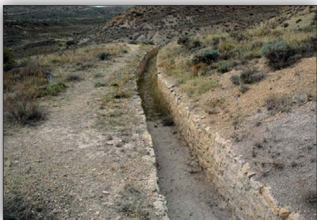
Canal en obra de fábrica en la zona anterior al gran túnel.
