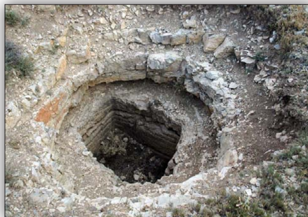
Segundo pozo de registro hoy señalado en término de Cella. Se observa un saneamiento inicial de la roca fragmentada antes de proceder a escuadrar el pozo.
