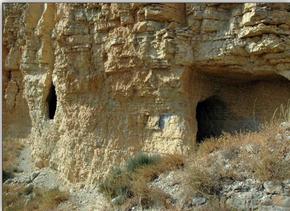
Tramo de canal desaparecido por los desprendimientos en la roca poco homogénea y escasamente compacta, en los escarpes del Azud de Gea.
