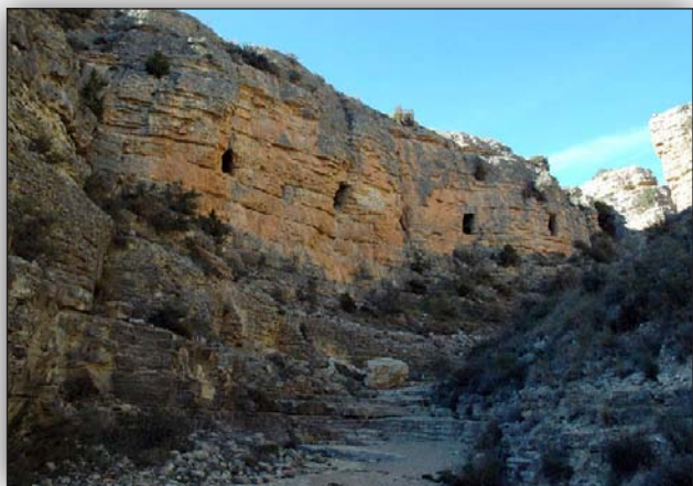
Registros en forma de ventana en el canal del acueducto, en el escarpe del barranco de los Burros.
