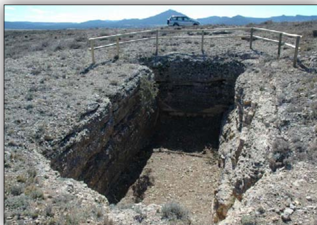
Boca de grandes proporciones o base mayor del tronco de pirámide invertido que forma uno de los pozos de registro mayores del túnel largo.
