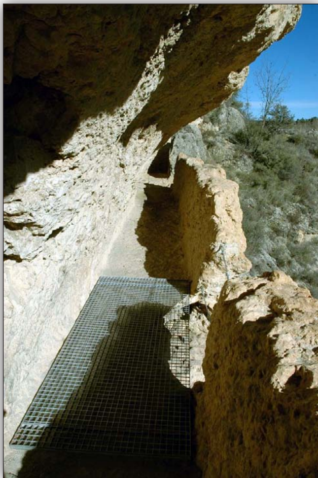
Cajero del canal sobre el túnel de la carretera de Gea a Albarracín.
