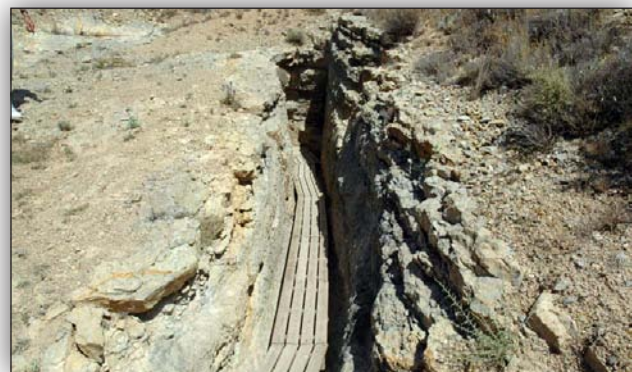
Aliviadero ejecutado justo antes de la entrada del gran túnel para evacuación de los caudales sobrantes que pudieran perjudicar la obra interior del túnel.
