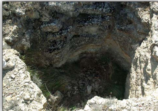
Boca de pozo de registro.
