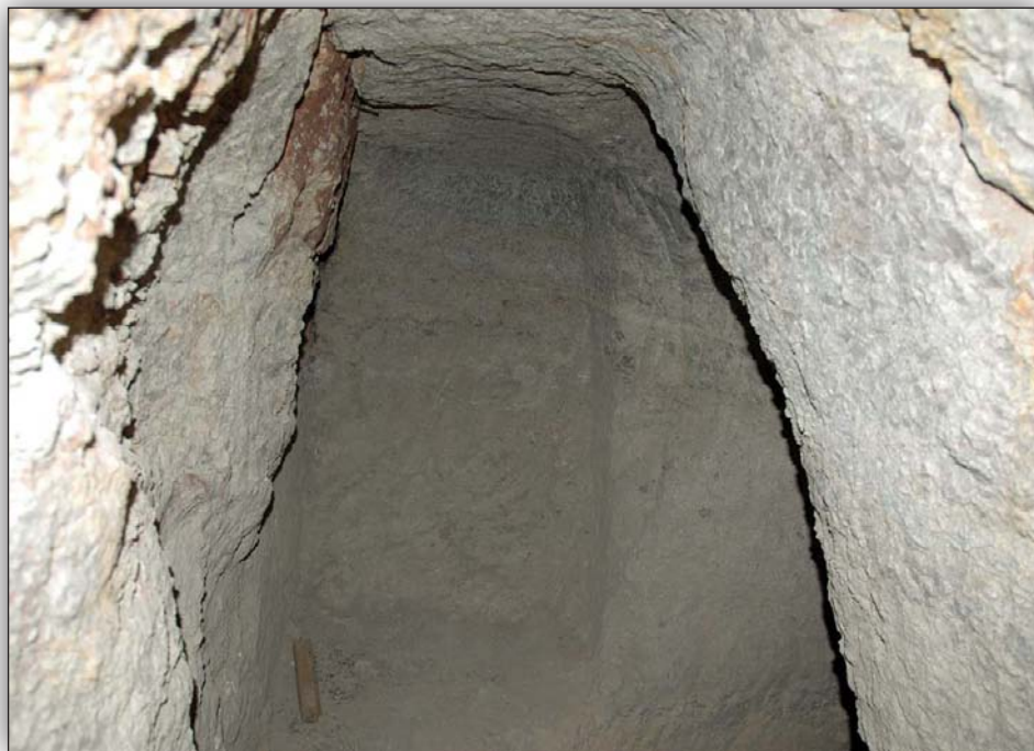
Final de la excavación en otra de las alineaciones en el túnel de la Cañada de Monterde. A la derecha la galería que da continuidad al canal.
