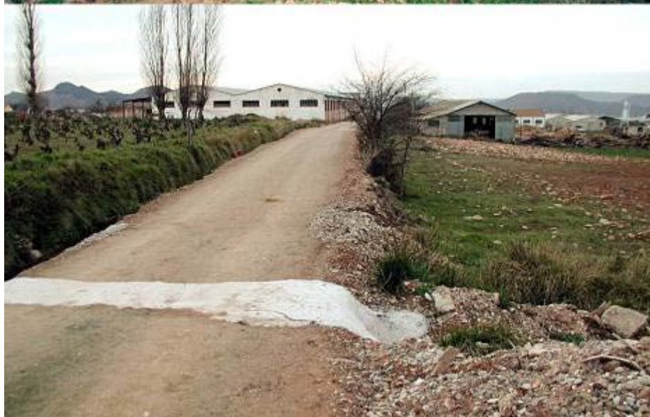
Arriba, el terraplén de la vía romana en Tricio (La Rioja) antes de su destrucción. Abajo, la infraestructura de la vía romana destruida por el reperfilado con máquinas motoniveladoras y el extendido de pavimento moderno, en enero de 2003, en el mismo punto que arriba.
