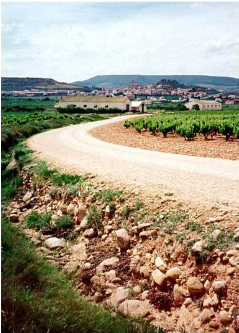
Cimentación a base de grandes bolos de canto rodado en la vía de Italia a Hispania, llegando a Navarrete. Camino de Lardero a Navarrete.
