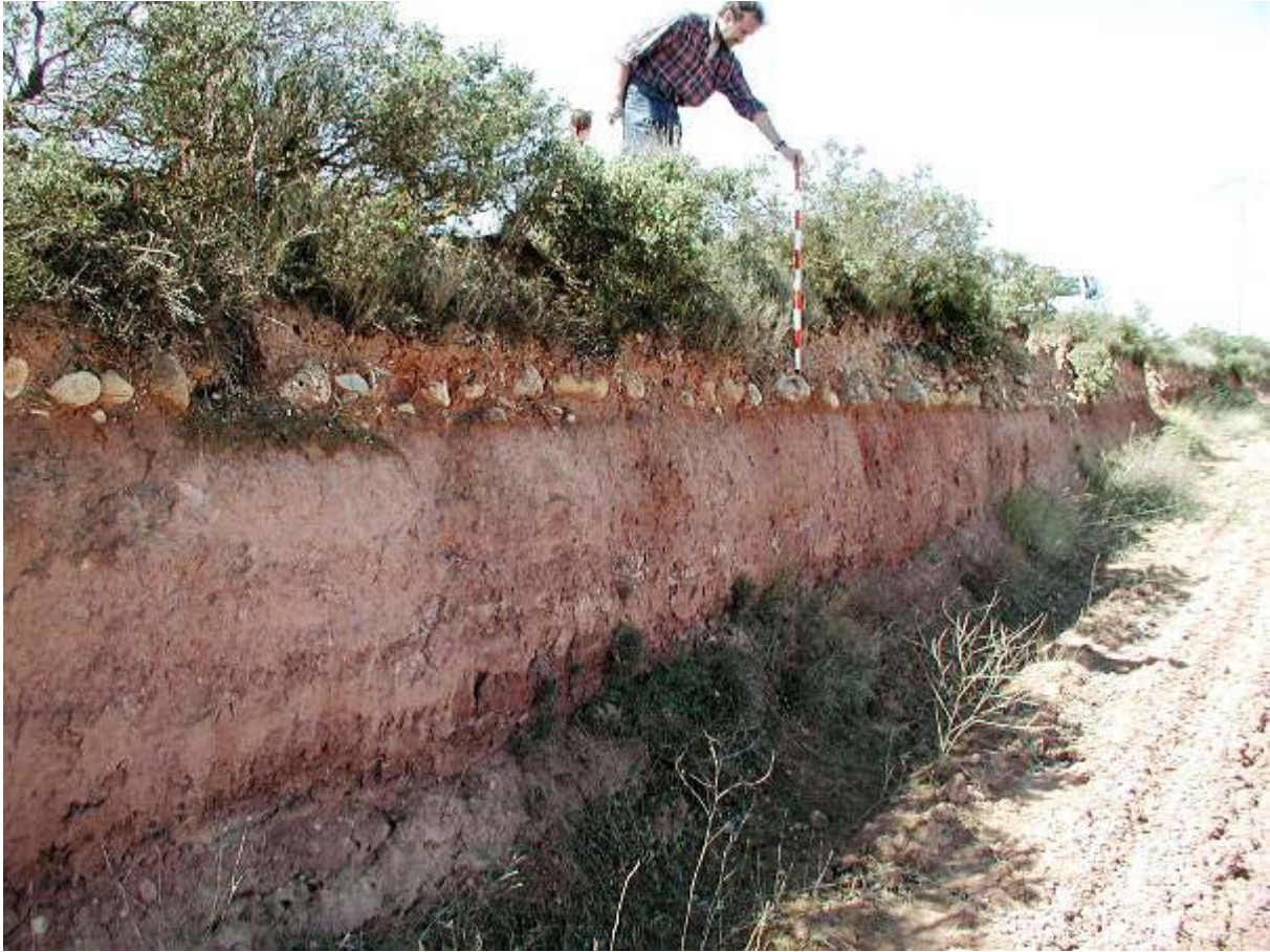
Cimentación de canto rodado en una sección lateral provocada por el abancalamiento de la finca colindante. Vía de Italia a Hispania entre el alto de San Antón y Alesón.
