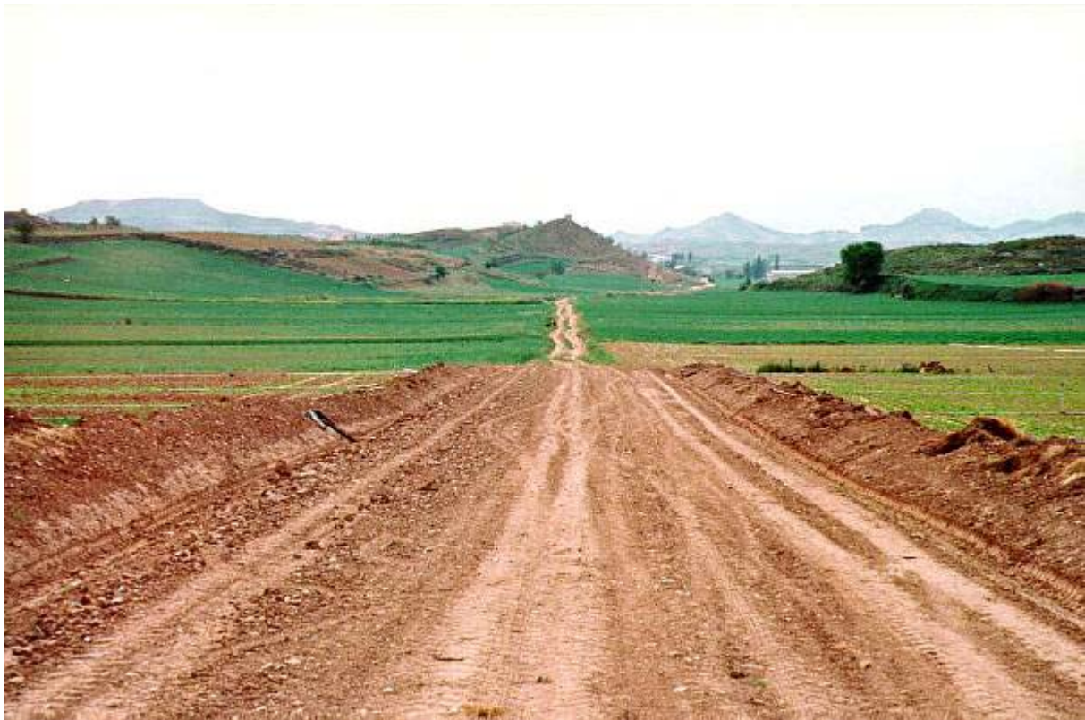
Obras de conversión en moderno camino agrícola (1999) de la Vía Romana de Italia a Hispania en el término de Azofra. Al fondo Hormilla y el “Camino de los Romanos” aún sin transformar.
