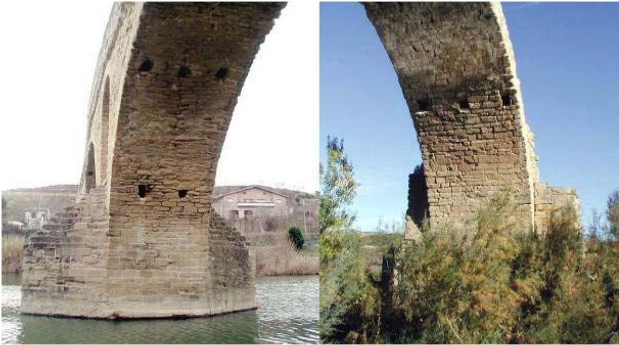
Detalle de la bóveda del Puente de la Reina a la izquierda y de la de Mantible a la derecha. Obsérvese en ambos el tamaño y la irregularidad del aparejo, el ancho y las proporciones de la rosca, la posición de los mechinales, etc.
