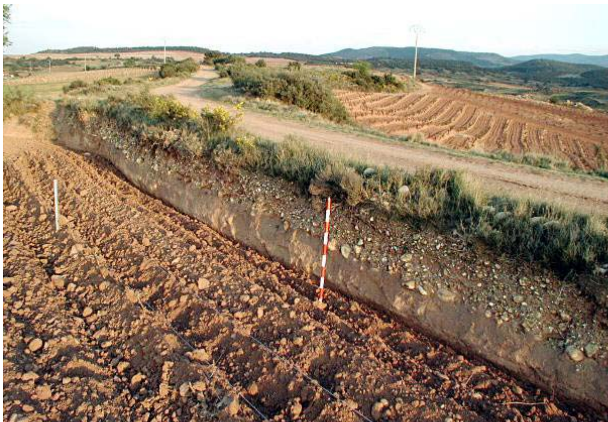
Detalle del espesor del afirmado en una sección lateral provocada por el abancalamiento de la finca colindante. Vía de Italia a Hispania entre el alto de San Antón y Alesón.
