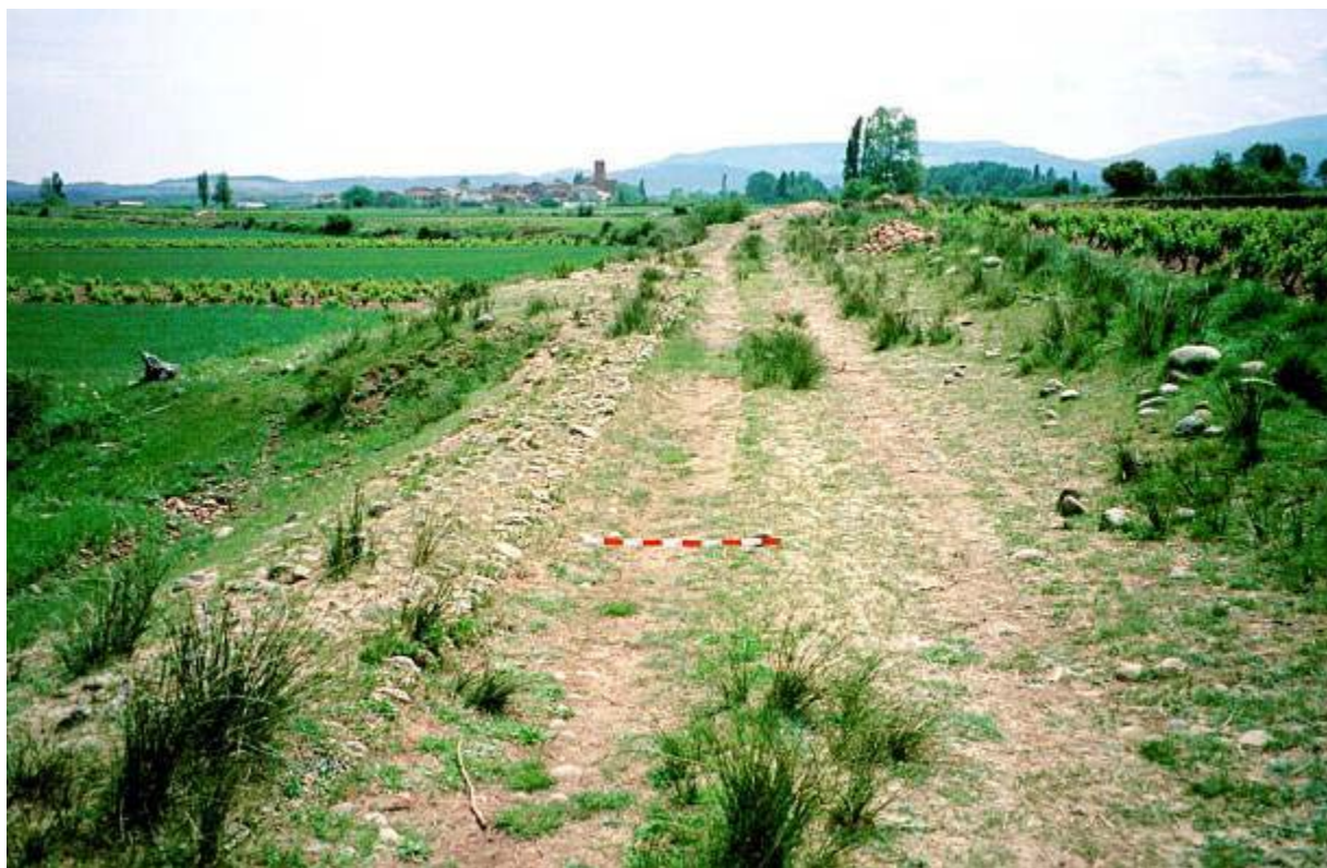
Terraplén perfectamente conservado con restos del bordillo de coronación en la Vía de Italia a Hispania en Tricio. Al fondo, Alesón.
