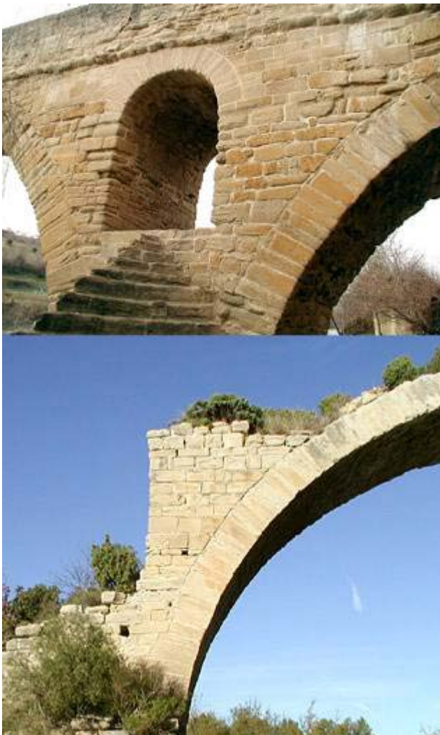
Detalle de la bóveda del Puente de la Reina a la izquierda y de la de Mantible a la derecha. Obsérvese en ambos el tamaño y la irregularidad del aparejo, el ancho y las proporciones de la rosca, la posición de los mechinales, etc.
