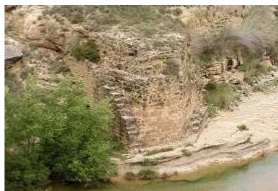
Aspecto de los restos conservados del el estribo derecho donde se aprecia el ancho revestimiento exterior a base de hiladas de grandes sillares.
