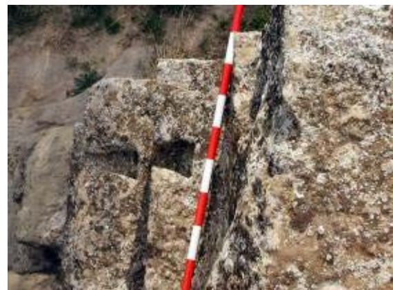
Detalle de las grapas de unión de los sillares en forma de cola de milano.
