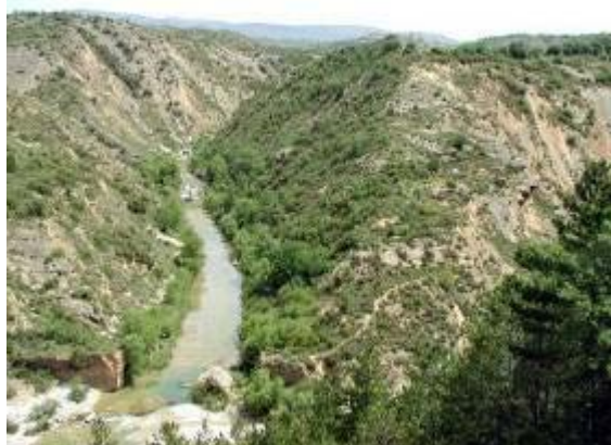
Restos de un puente de dos ojos sobre el río Alcanadre, en el Camino de Casbas de Huesca a Bierge, cuya población se
