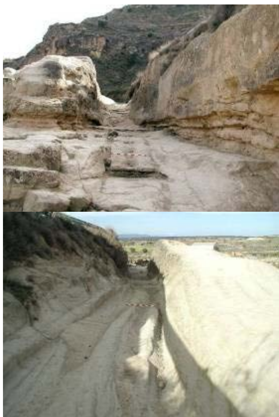
Trinchera excavada en roca a la salida de Pertusa, con rodadas de carro, perteneciente al Camino Viejo de Zaragoza o Camino de Monzón a Pamplona descrito por Villuga.
