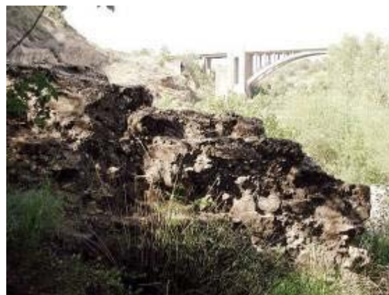
Restos del estribo derecho de un viejo puente en el paso del Alcanadre en Las Cellas, aguas abajo de otras obras modernas.
