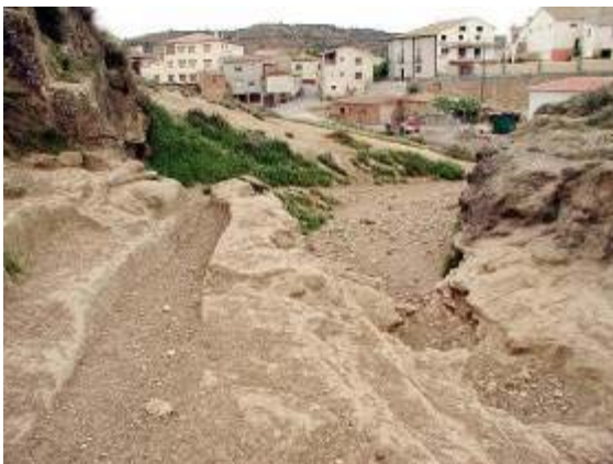
Cuneta entallada en la roca para drenaje de la vía en Pertusa.
