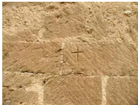
Repicado del paramento interior del relleno para la reutilización de la estructura superviviente. Se observan las marcas del repicado sobre las propias juntas y una marca en cruz moderna en el sillar.
