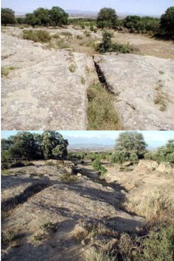
Cuneta entallada en la roca durante mucha longitud para el drenaje de la vía romana de Ilerda a Oscá en Berbegal.
