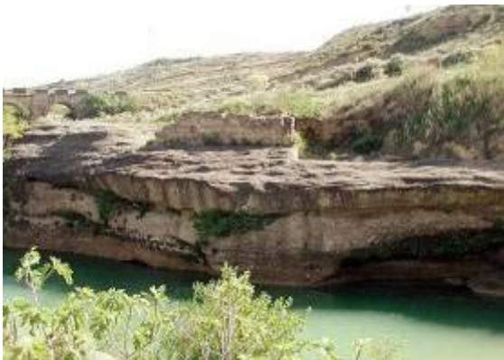
Restos del estribo derecho del viejo paso del Camino Real de Monzón a Zaragoza, sobre el río Alcanadre, en Peralta de Alcofea.
