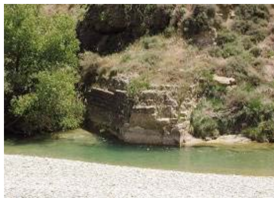
Restos del estribo izquierdo del paso del Camino viejo de Zaragoza o Camino Real de Monzón a Pamplona sobre el río Alcanadre en Pertusa.
