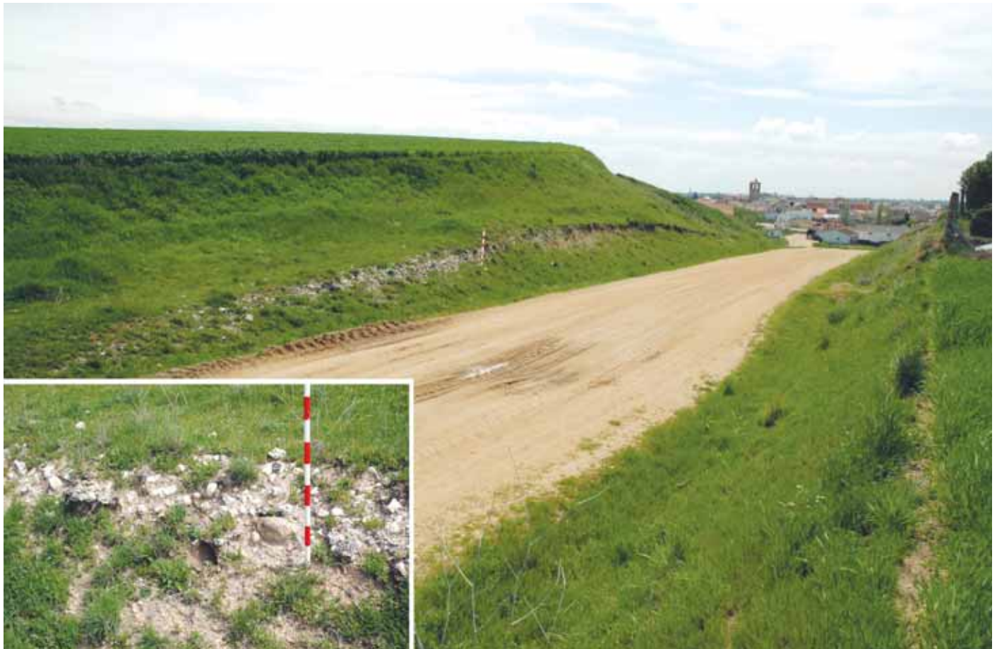
Fig. 40. El paquete de firmes seccionado en la vía romana en el fondo antiguo del desmonte en trinchera. Está compuesto de cimentación de bolos de gran tamaño y de capas de piedra de cuarzo. Al fondo, Calzada de Valdunciel (Salamanca).
