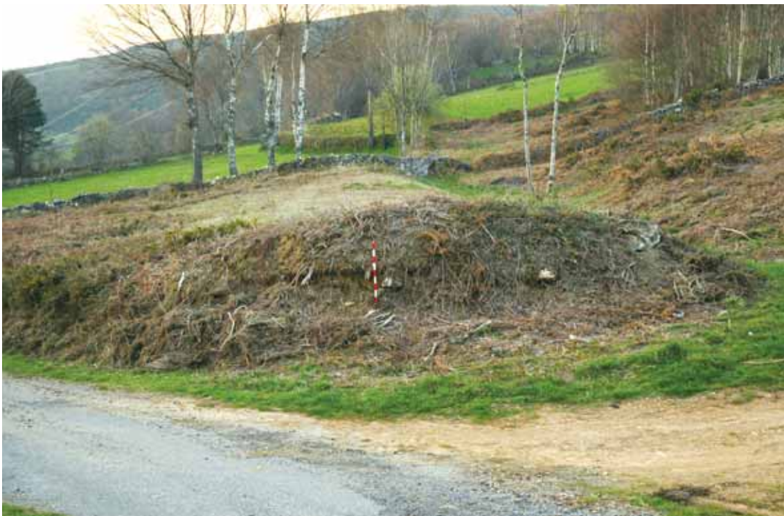
Fig. 16. Sección del terraplén de la vía romana donde se ven los tamaños gruesos de la cimentación y el material granular superior.
