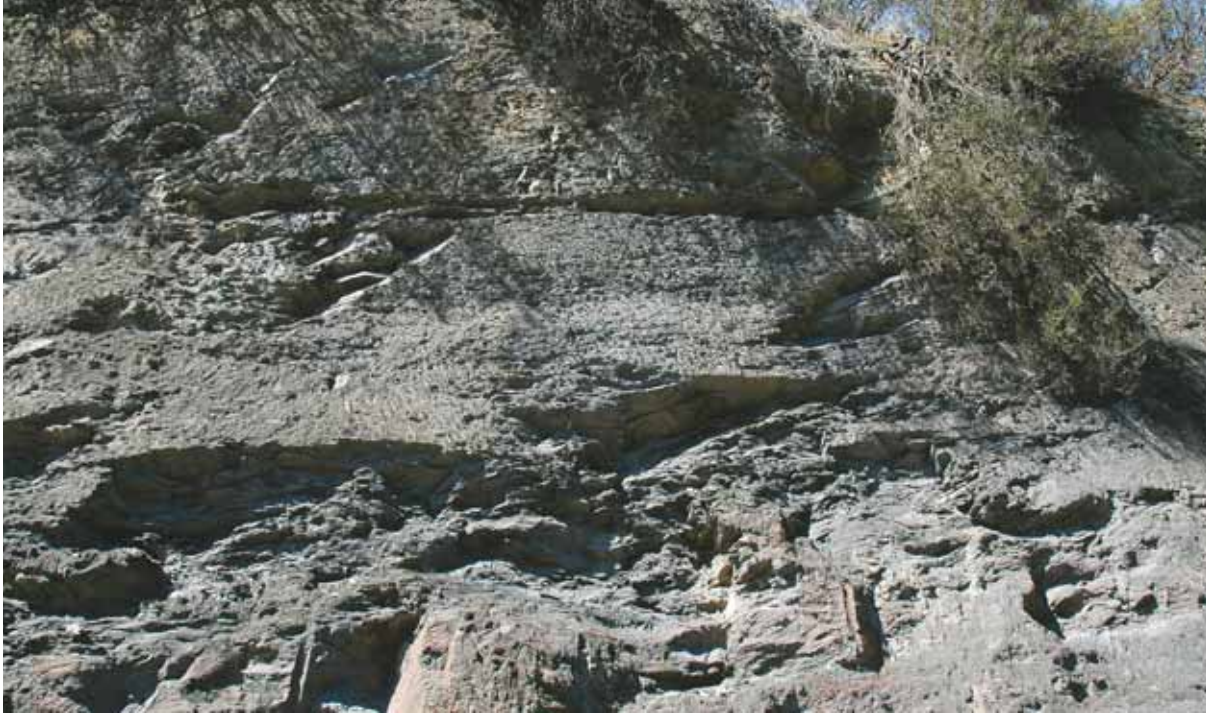
Fig. 12. Desmonte romano a golpe de pico sobre otros modernos barrenados. Obsérvese las huellas de los barrenos.
