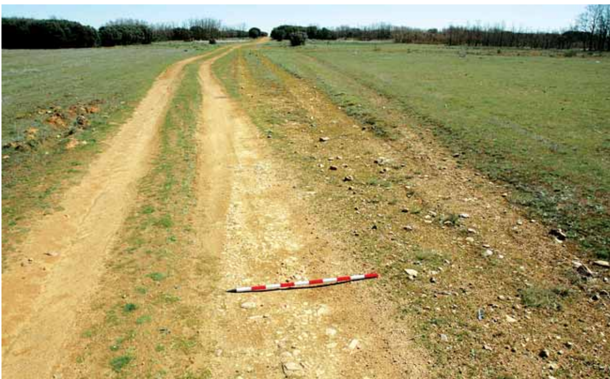
Fig. 29. La vía romana entrando en el monte de Villar de Mazarife. Se ve claramente la grava alineada de la vía resaltando en el terreno natural arcilloso.
