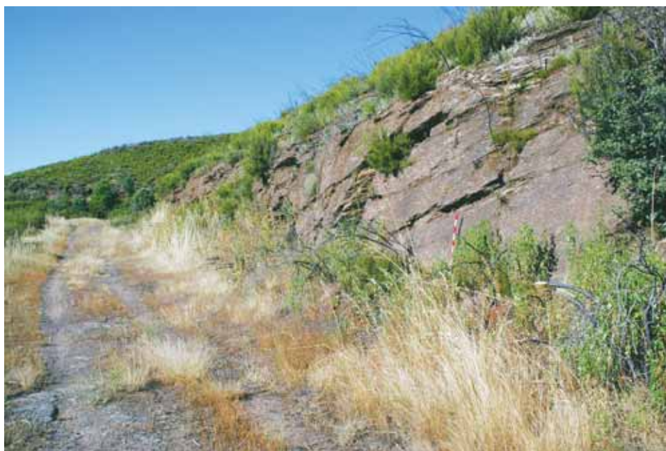
Fig. 9. Desmorte en roca esquistosa, tallado a pico, donde se ven aún los golpes de las herramientas, en el Camino de los Romanos entre Cabarcos (León) y Porto (Orense).
