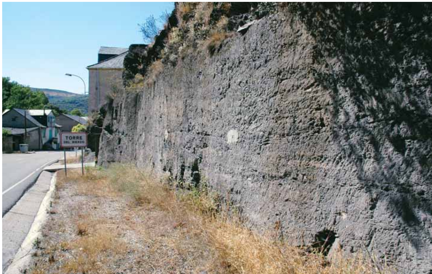
Fig. 14. Desmorte a pico con buena geometría a la entrada de Torre del Bierzo.
