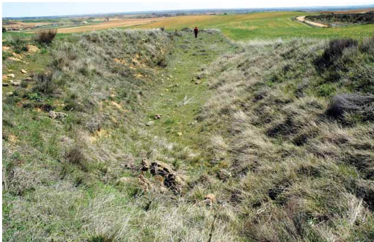
Fig. 25. Trinchera de la vía romana en el Camino de los Valdesogos a León.
