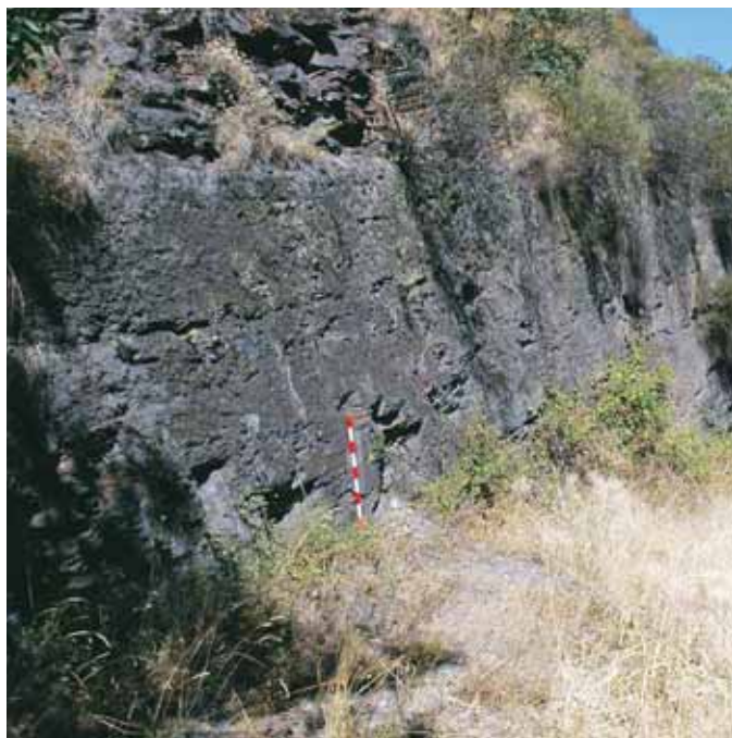
Fig. 10. Taludes de los desmontes en roca esquistosa con la misma geometría que los de Cabarcos y con los golpes de pico bien perceptibles. Desmontes de la vía romana, aprovechados por Lemaur aunque aquí se separó de ellos, en Torre del Bierzo, a orillas del río Tremor y no muy lejos del río Boeza
