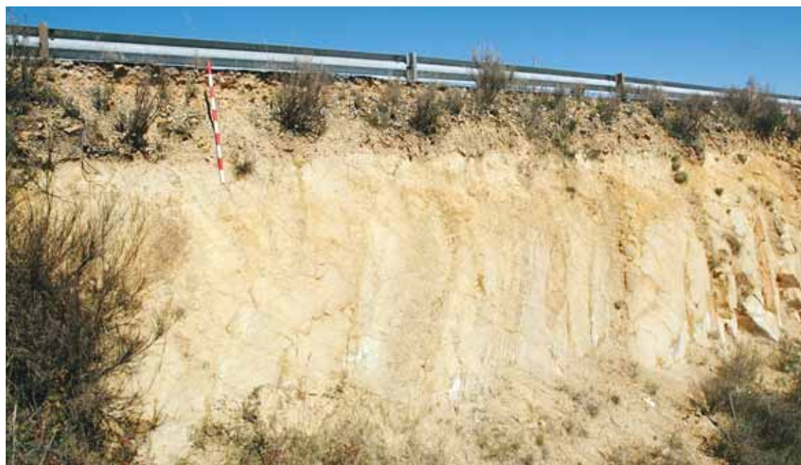
Fig. 7. Grueso paquete de zahorra natural del camino viejo, la vía romana, en Combarros. Sobre él la carretera antigua también seccionada.
