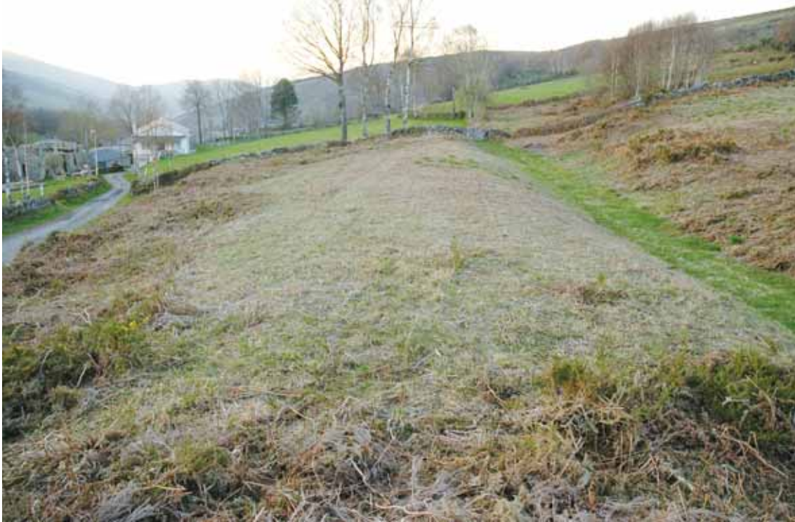
Fig. 15. Terraplén de la carretera romana en Comeal (Lugo) en el mismo límite de Castilla y León y Galicia. A la derecha la cuneta del drenaje longitudinal.
