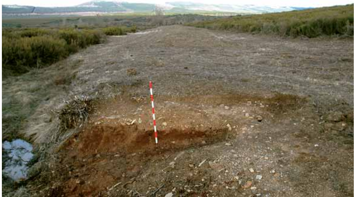
Fig. 6. Material pétreo de mediana calidad en la coronación del terraplén cercano al arroyo de Sobacana, en Figueruelas de Arriba (Zamora).
