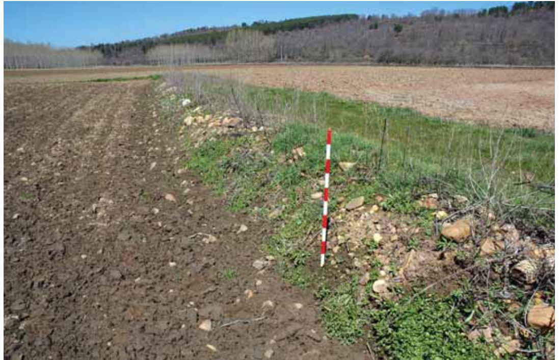
Fig. 19. Terraplén del Camino Viejo de Astorga, compuesto de gravas, hoy abandonado y labrado en Castrillo de Cepeda.
