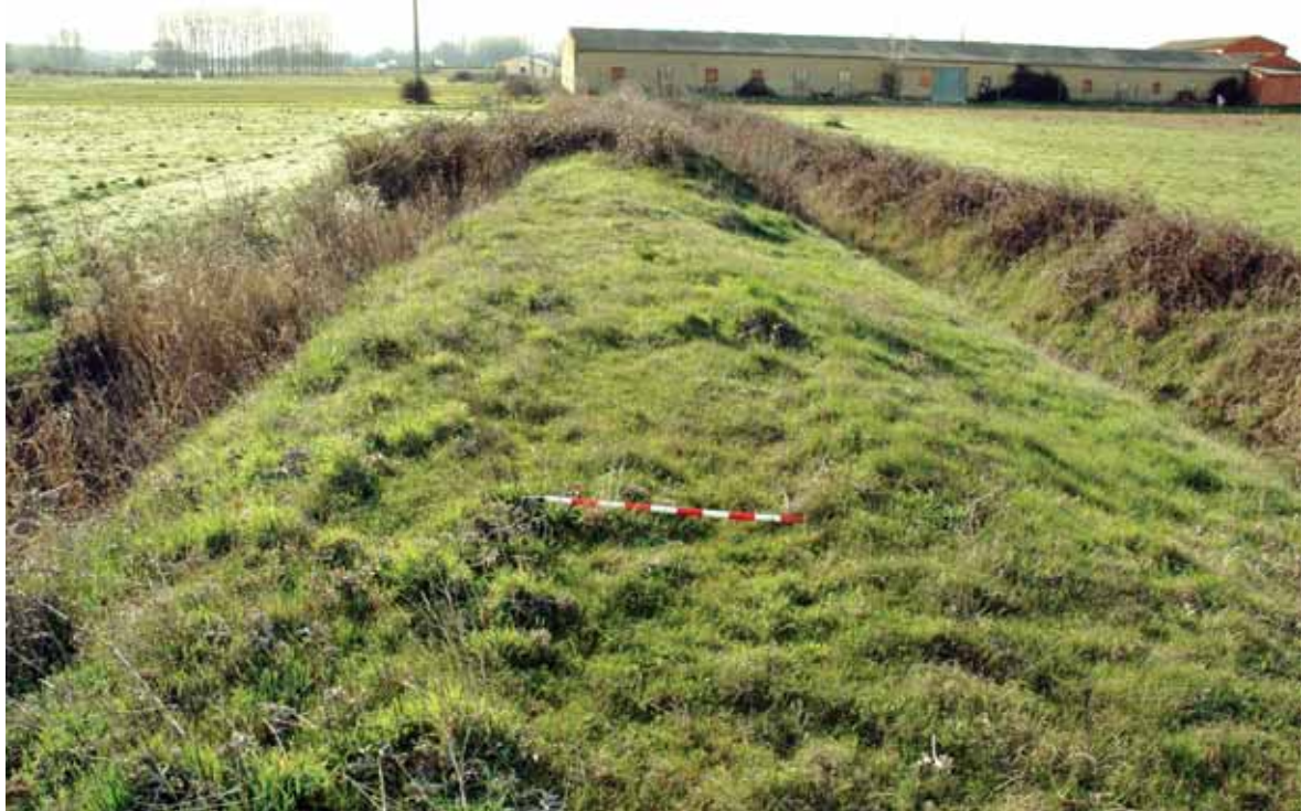
Fig. 37. Último vestigio del terraplén de la vía romana en el barrio de San Mamés de la Bañeza. En el entorno pueden verse las piedras gruesas de la cimentación sacadas por los arados.
