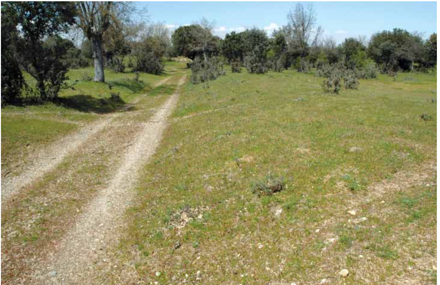
Fig. 41. Terraplén de la vía romana, fosilizado a la derecha del camino actual, al sur de San Cristóbal del Monte.
