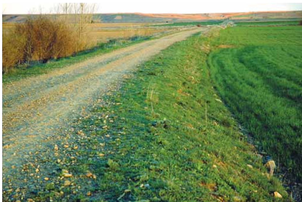
Fig. 26. Terraplén de la Calzada de los Peregrinos en Mansilla de las Mulas. Conserva en parte la estructura primitiva aunque fue sometido a una severa transformación en las labores de concentración parcelaria.
