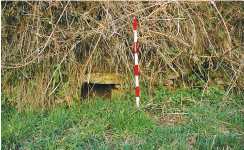
Fig. 17. Pequeña tajea de drenaje transversal de la vía romana, hoy integrada en el lindero de las fincas en Comeal.
