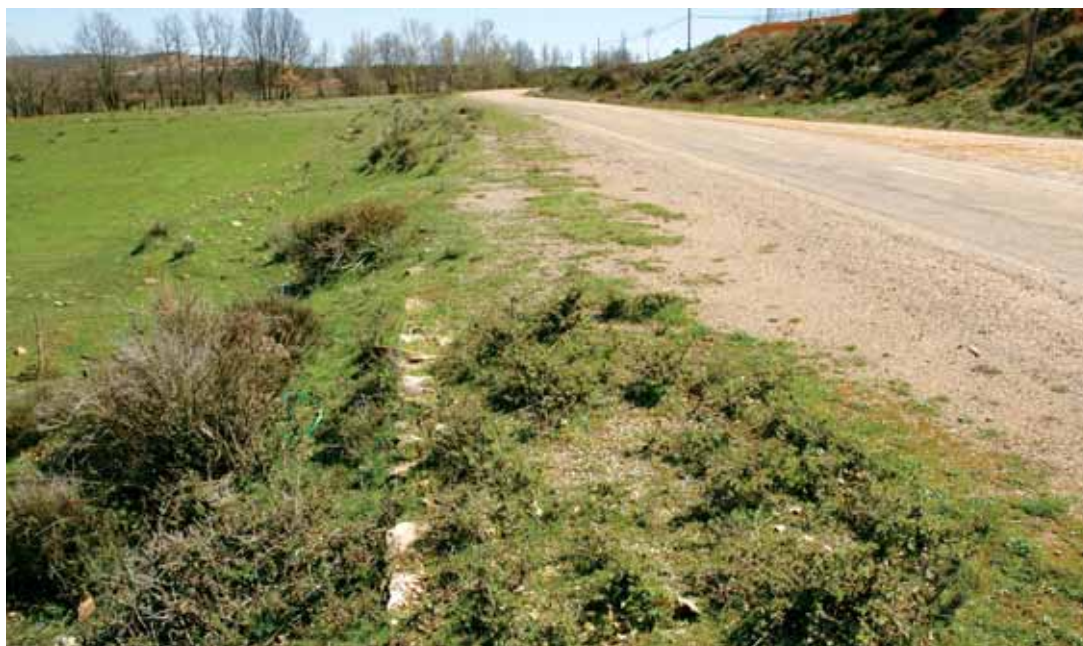
Fig. 8. Restos del bordillo del camino más antiguo, que aquí quedó abandonado por el trazado de la carretera antigua, en la travesía de Combarros
