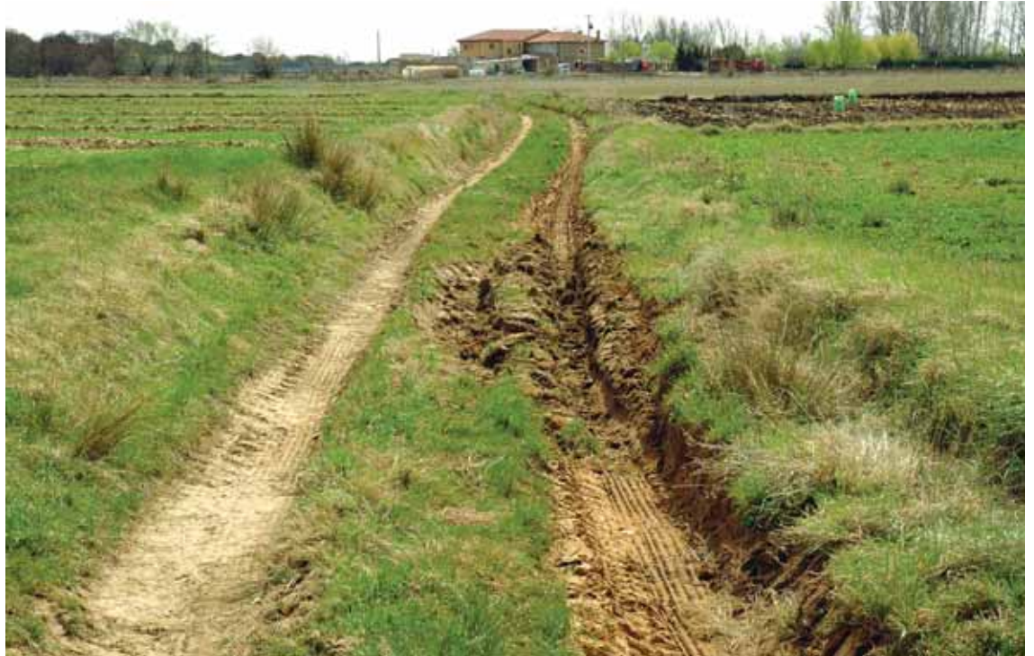
Fig. 34. Aspecto del terreno y de su capacidad portante en el camino de la Cañada Real de la Vizana, homogéneamente malo entre San Juan de Torres y el Puente de la Vizana. En este caso, en Alija de los Melones. Al fondo, la casa del puente de la Vizana.
