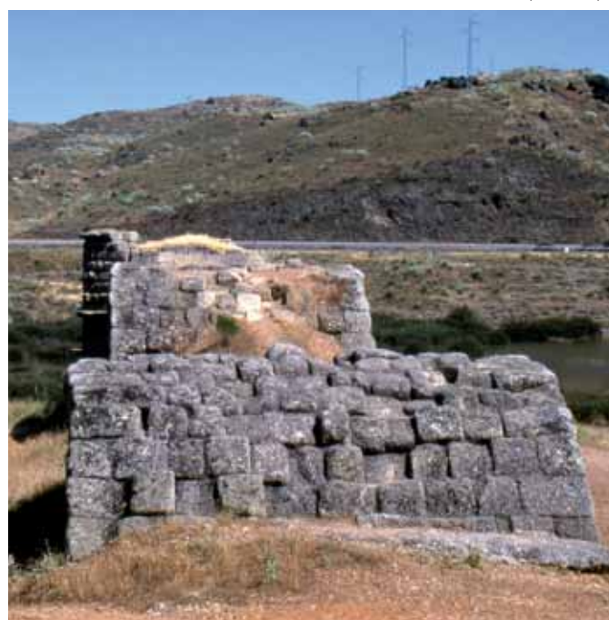
Fig. 12. Espesor uniforme de una bóveda del puente de Alconétar (Cáceres).
