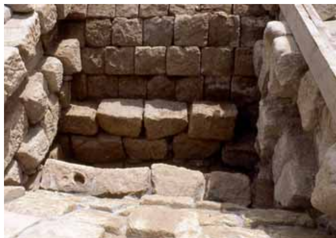
Fig. 15. Refuerzo interior con una segunda rosca en una bóveda del Ponte Freixo (Ourense).
