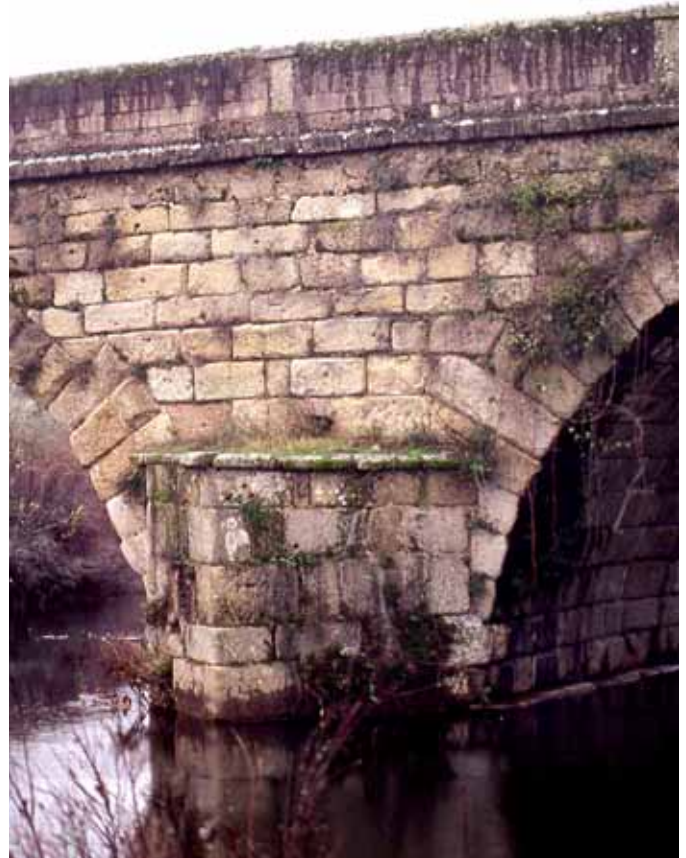
Fig. 17. Dovelas de mayor tamaño en la parte baja del puente de Caparra.
