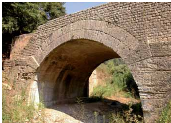
Fig. 14. Doble rosca en el Ponte delle Fate (Italia).
