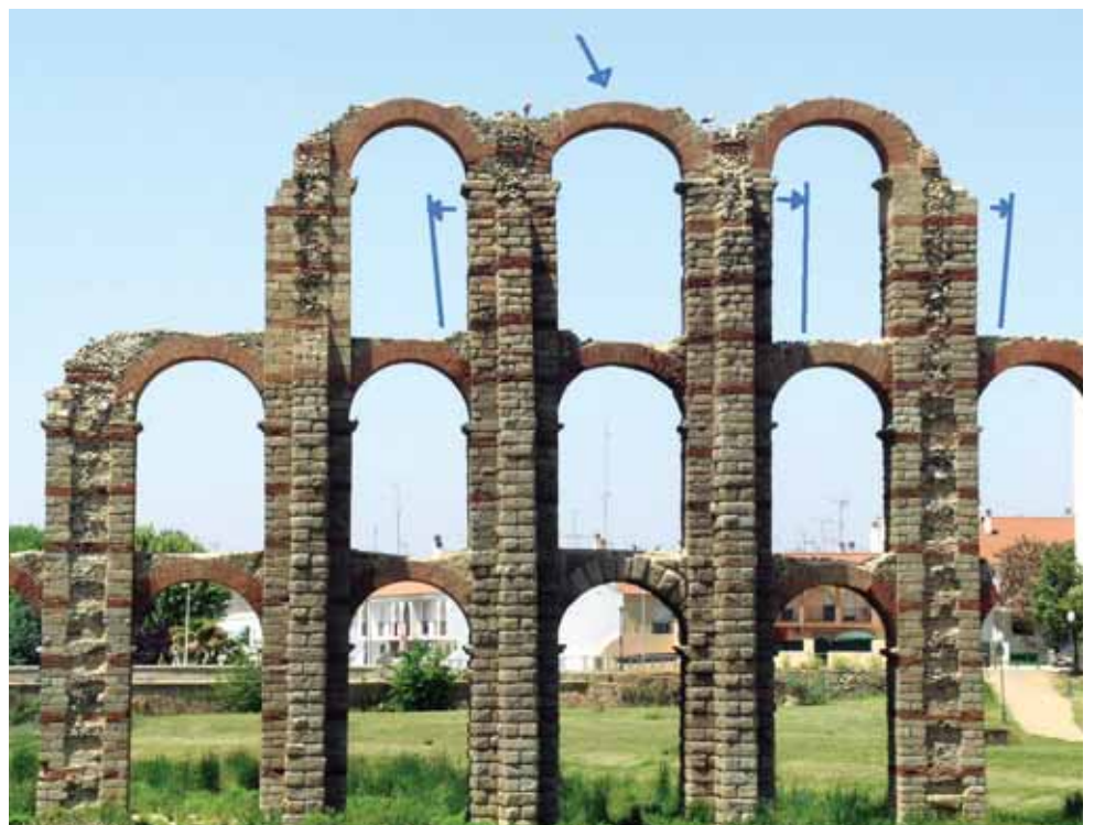
Fig 10. Deformaciones de los pilares debido a la falta de contrarrestos (antes de hacerse la restauración actual).
