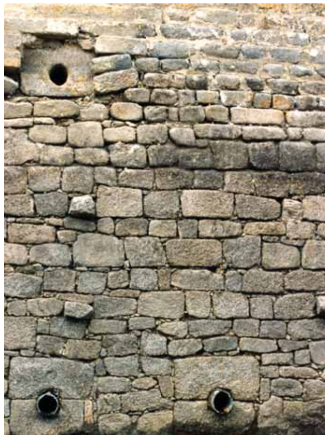
Fig. 19. Primera fase de Proserpina con una sillería completamente irregular.
