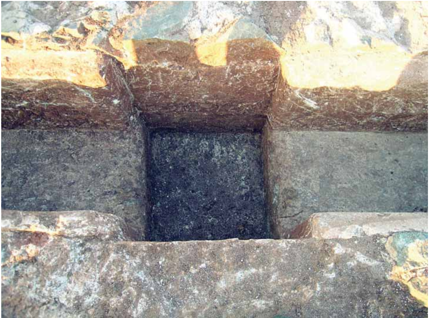
Fig.6. Rebajes en los pozos de registro.
