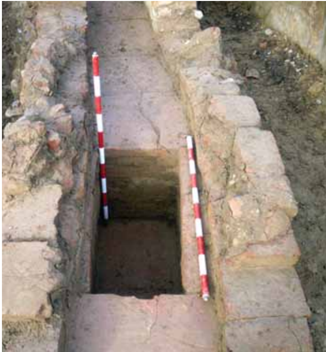
Fig. 4. Desarenador aguas abajo de la curva.
