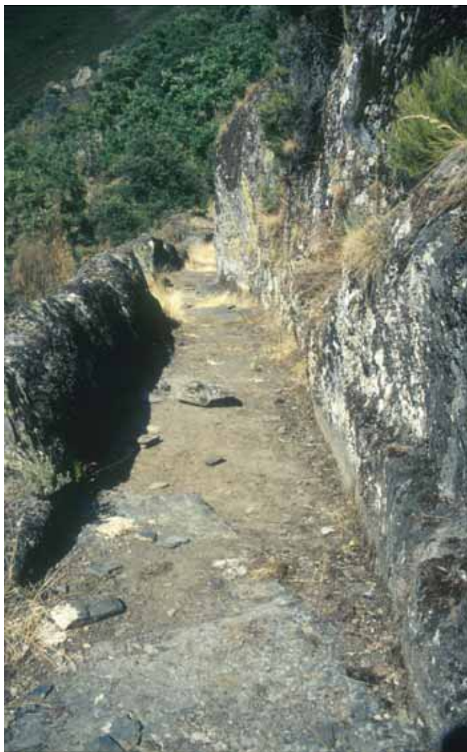
Fig. 18. Detalle de uno de los canales mineros existentes en el valle del Cabrera.
