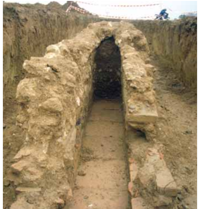
Fig. 5. Restos de un segundo desarenador aguas arriba de la curva.
