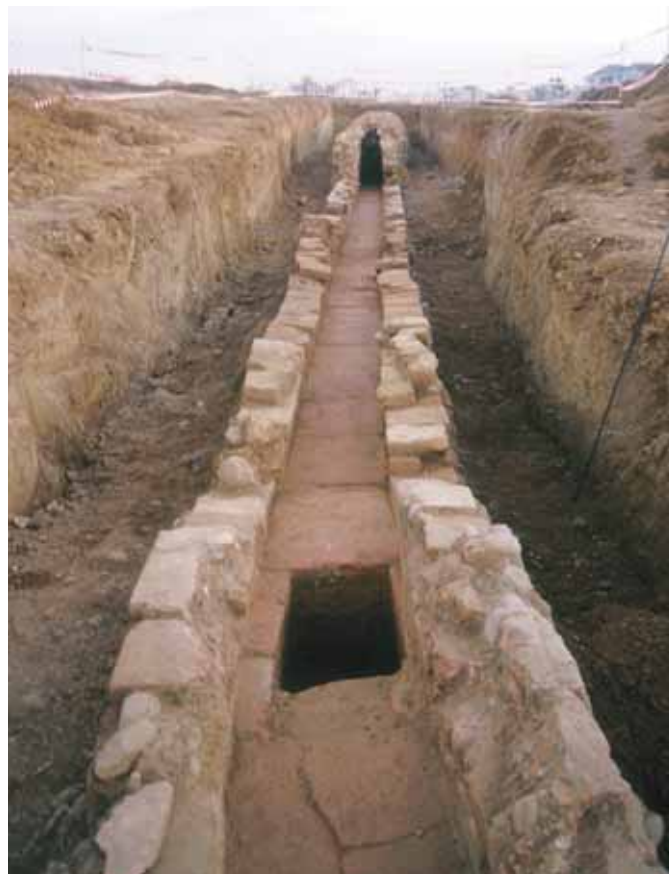
Fig. 3. Vista general del acueducto.
