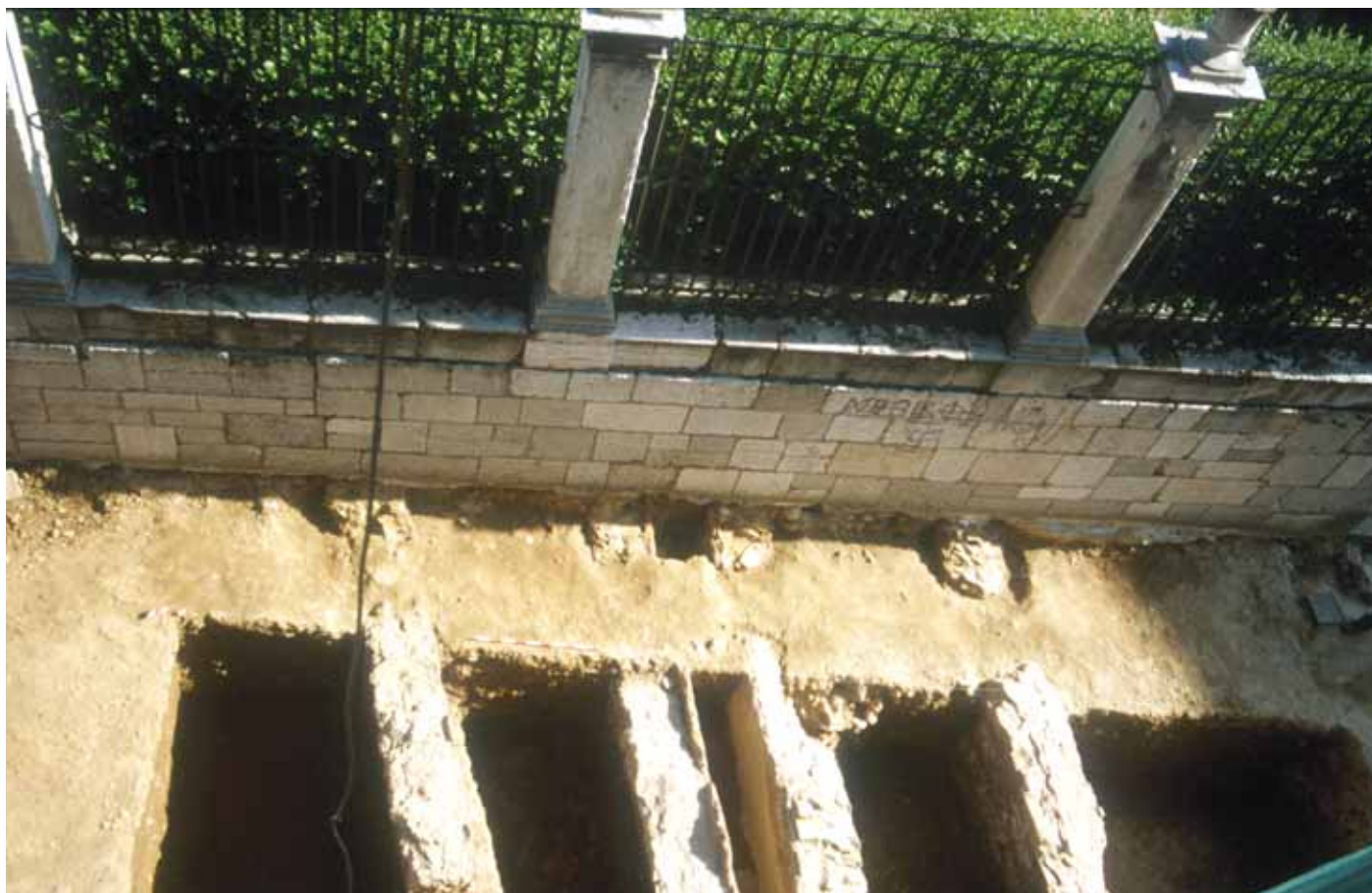
Fig. 14. Vista general de las excavaciones en la calle Abadía.
