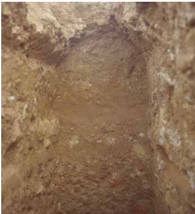
Fig. 6. Bóveda con detalle de las improntas del encofrado.
