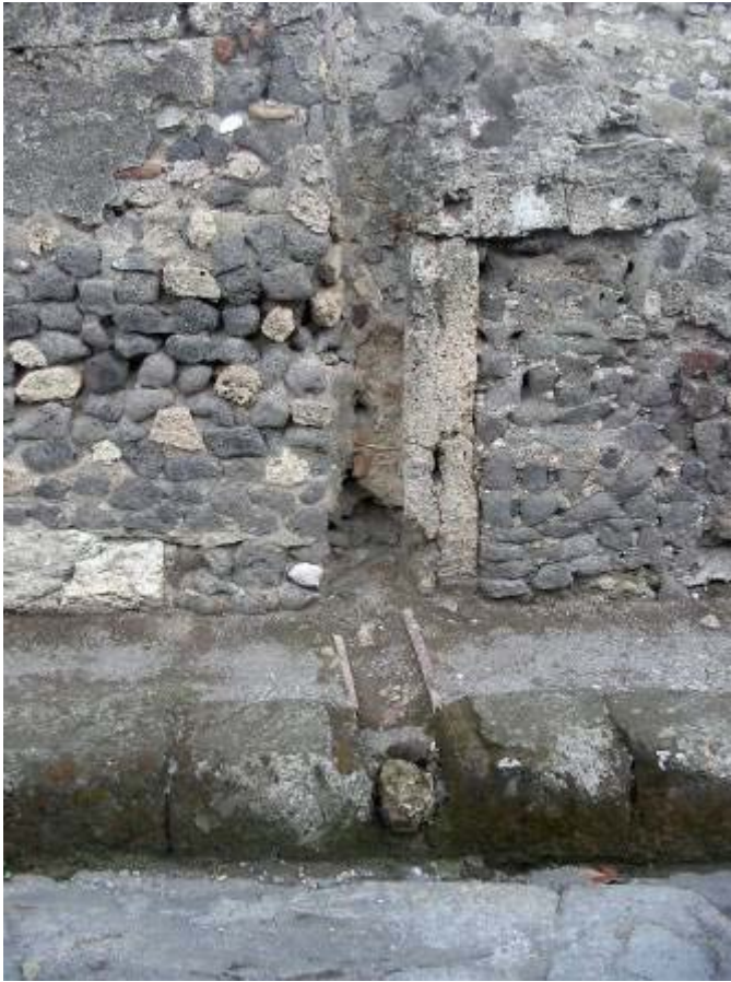
Figura 13: Desagüe de una casa en Pompeya, directo a la calzada (foto C.Redondo)
