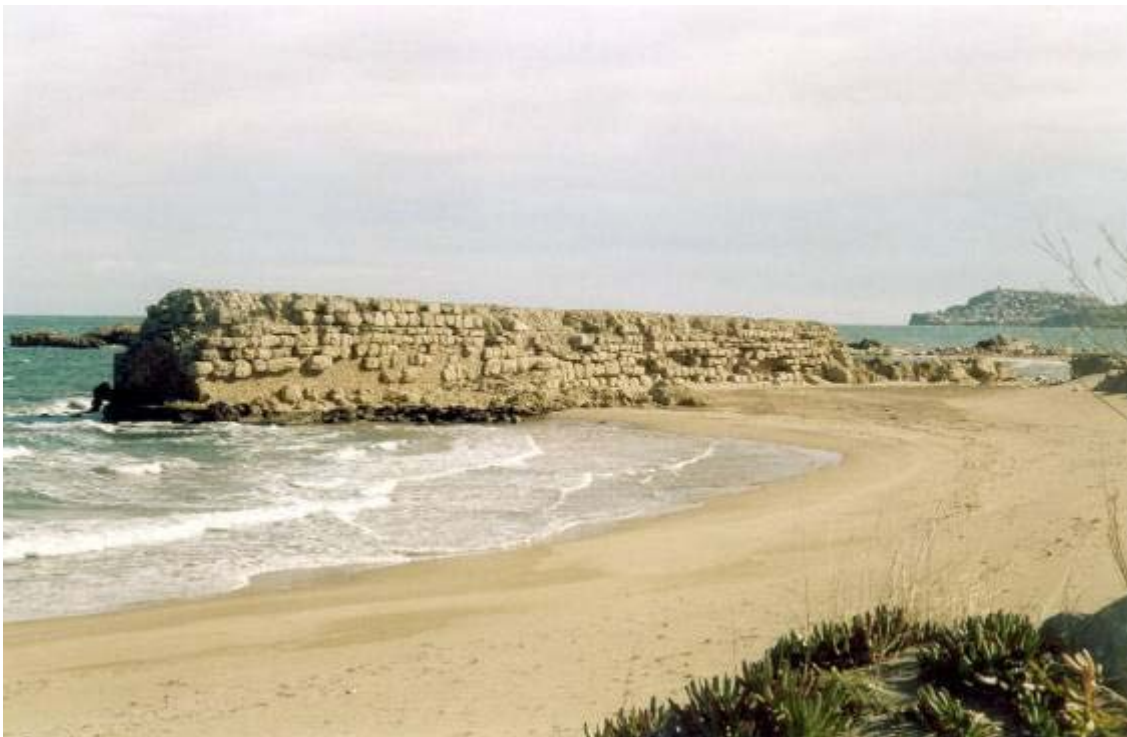
Figura 16: Dique romano de Emporion
