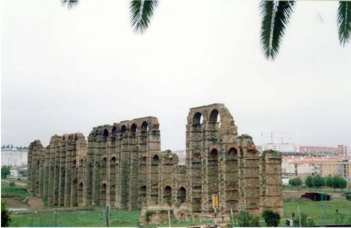
Figura 14: Acueducto de los Milagros en Mérida
