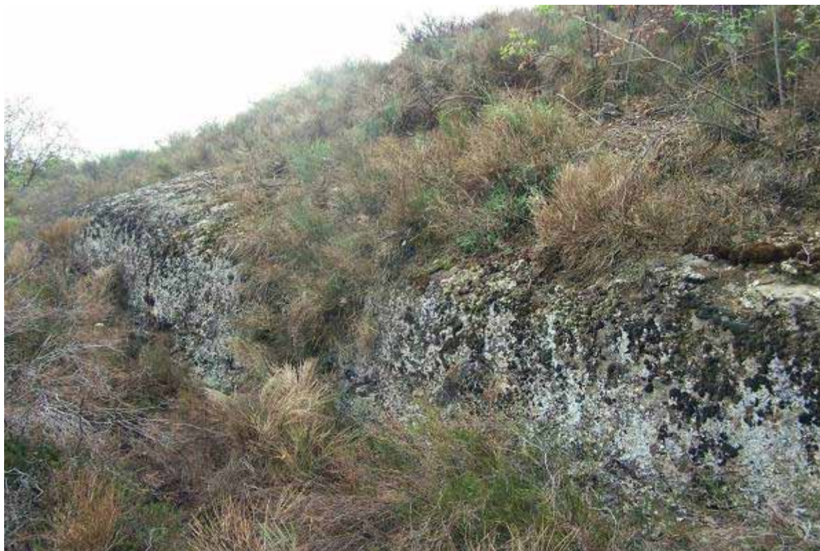
Photo 9 : Détail de la tranchée au Collenon
