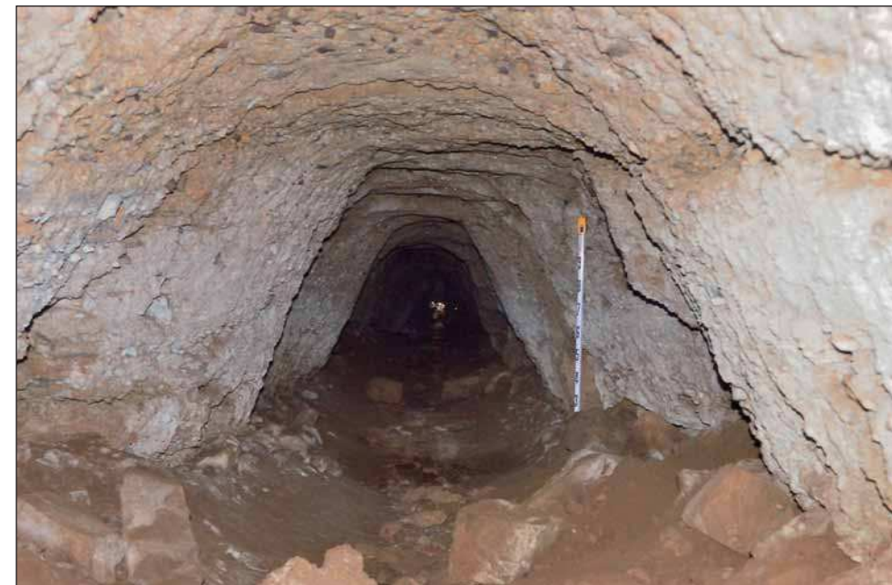
Interior del túnel de Prado Herrero.
