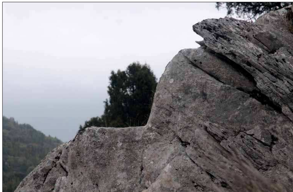
Escalón de asiento para el muro de cierre del canal (Camino Griego-Arroyo de Valdehaya).
