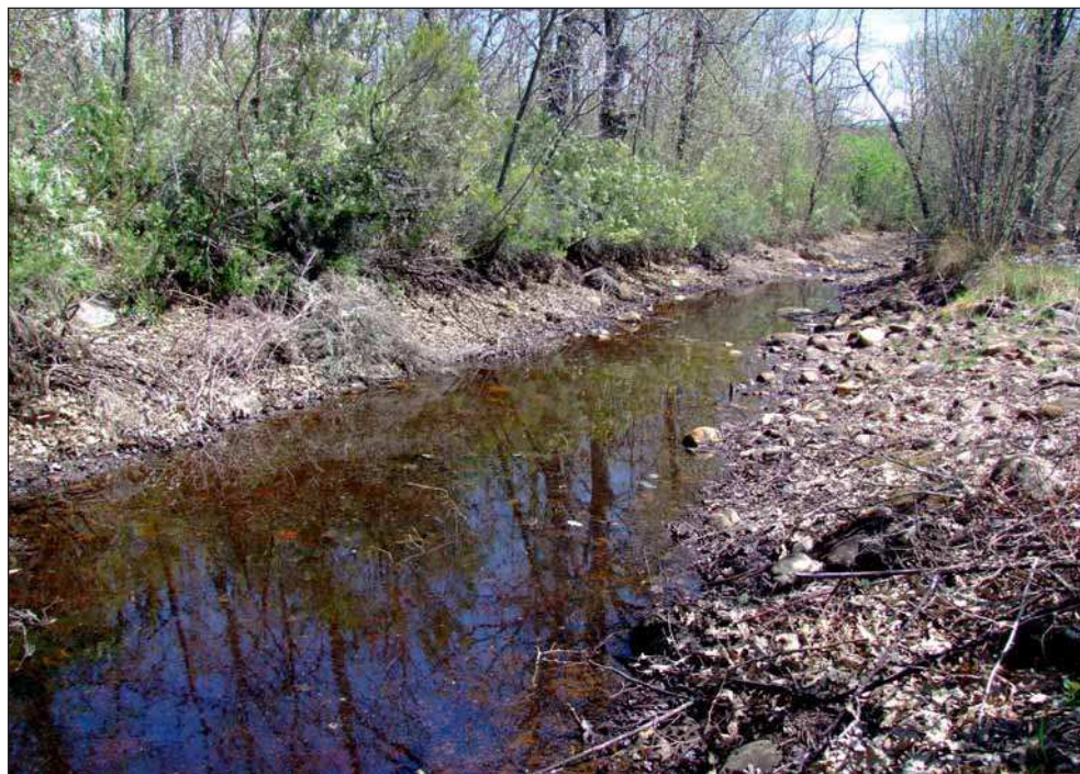
Mantinos (margen izquierda): canal de lavado original oculto entre la vegetación.
