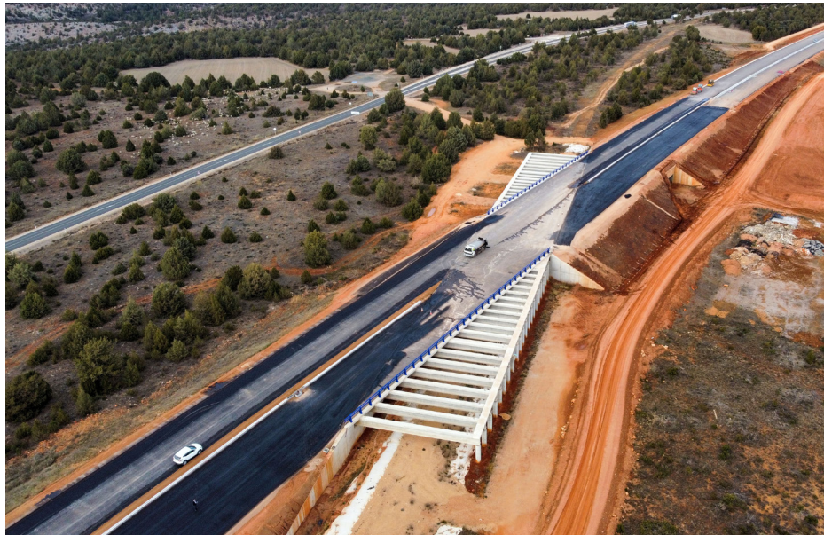
Una de las pérgolas sobre la vía romana en la autovía A-11. Elevando esta en su perfil longitudinal apenas dos metros se liberó la vía romana dando continuidad al corredor de esta.
