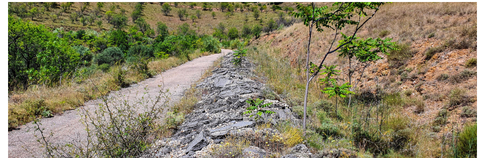
Tramo abandonado de la antigua N-II entre el Frasno y Morata de Jalón (Zaragoza). A finales de los años 80 se utilizó en una gran longitud como lugar de vertido de los escombros de demolición de otras partes de la carretera, cuando se construyó la moderna autovía A-2, estrechando con ello enormemente la plataforma.
