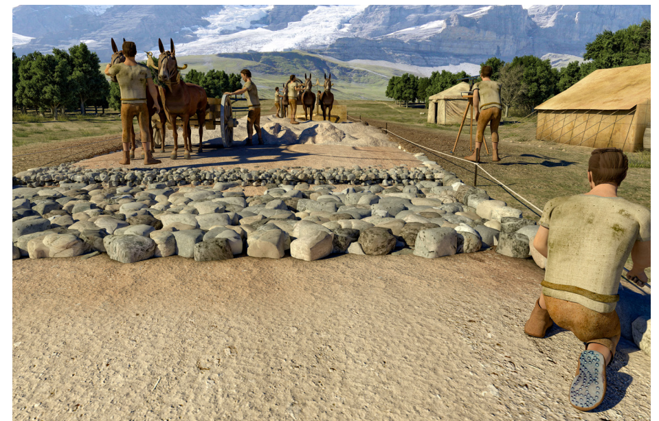
Infografía que representa el trabajo de alineación de los bordillos y los operarios que intervienen. En la bota del que está en primer plano, de espaldas, podemos ver las tachuelas que en tan gran número se han encontrado.
