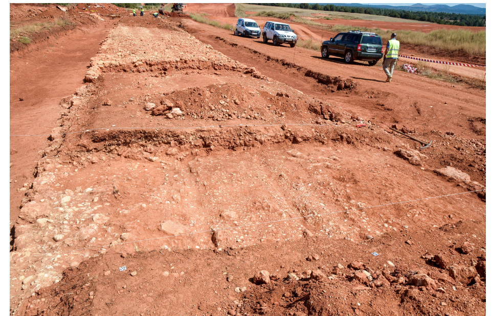
Proceso de excavación minuciosa de la vía romana de Numancia a Osma, donde se ven claramente la impronta de las ruedas de los carros de construcción, rodadas que quedaron grabadas cuando los carros basculantes extendían las capas superiores del afirmado tapando sus propias huellas.
