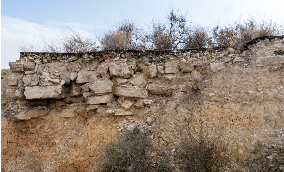
Corte de la antigua carretera N-II en Peñalba (Huesca). Esta sección merece un análisis detallado porque, además de coincidir aquí con el trazado de la vía romana entre Velilla de Ebro a Lérida, se observa un afirmado del siglo XVIII, un pequeño murete de contención, firme de macadam y tratamiento superficial de betún asfáltico en superficie.
