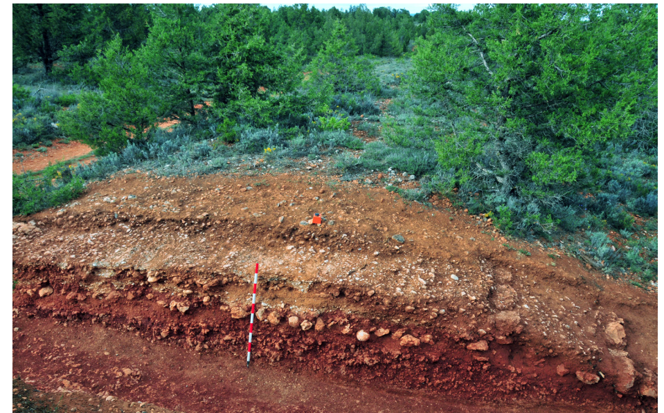
Sección estructural de la vía romana entre Numancia y Uxama seccionada y escalonada junto al Camino Real Viejo, en el término municipal de Calatañazor. La gran altura del terraplén aquí formado obligó a disponer de un doble bordillo en el lado sur de la carretera romana. El terraplén, unido a las capas del afirmado alcanzan una altura superior a un metro en esta zona. www.viasromanas.net
