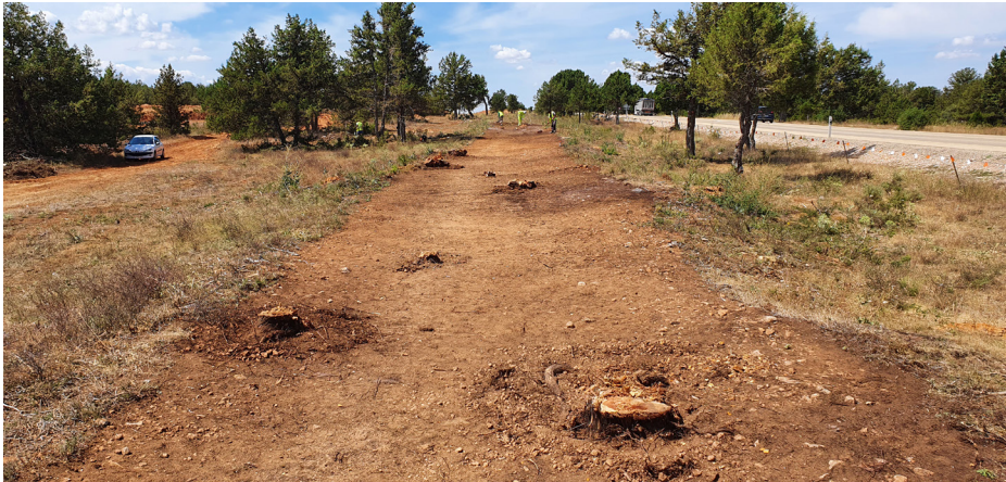
Labores de limpieza sobre la superficie de la calzada romana, una vez deforestada de los cientos de árboles que habían crecido sobre ella, para hacerla transitable únicamente por peatones y por bicicletas de montaña.
