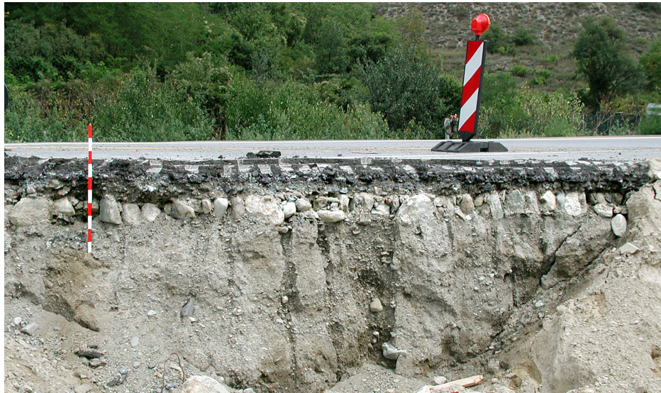
Vía romana bajo una carretera moderna en Aosta (Italia), seccionada longitudinalmente por unas obras. En España también son muy numerosos estos casos.
