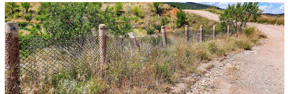
Tramo de la antigua N-II en el Frasno (Zaragoza) conservando el balizamiento correspondiente a Instrucción de Carreteras de 1939. Hoy es muy difícil encontrar estos elementos aún en pie.
