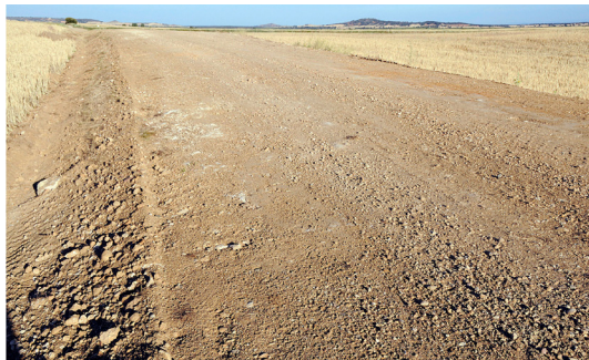
Arriba, aspecto de la vía romana en Caleruega, perfectamente conservada en agosto de 2005. Abajo, el mismo punto en julio de 2008, después de intervenida por los bulldóceres. www.viasromanas.net
