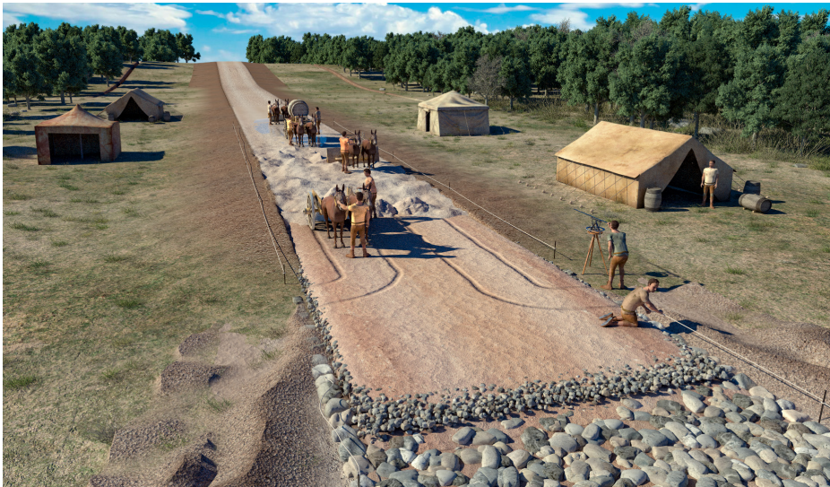
Proceso constructivo deducido de las sucesivas excavaciones arqueológicas en las que hemos buscado expresamente este tipo de pruebas que determinasen la metodología constructiva de las carreteras romanas.
