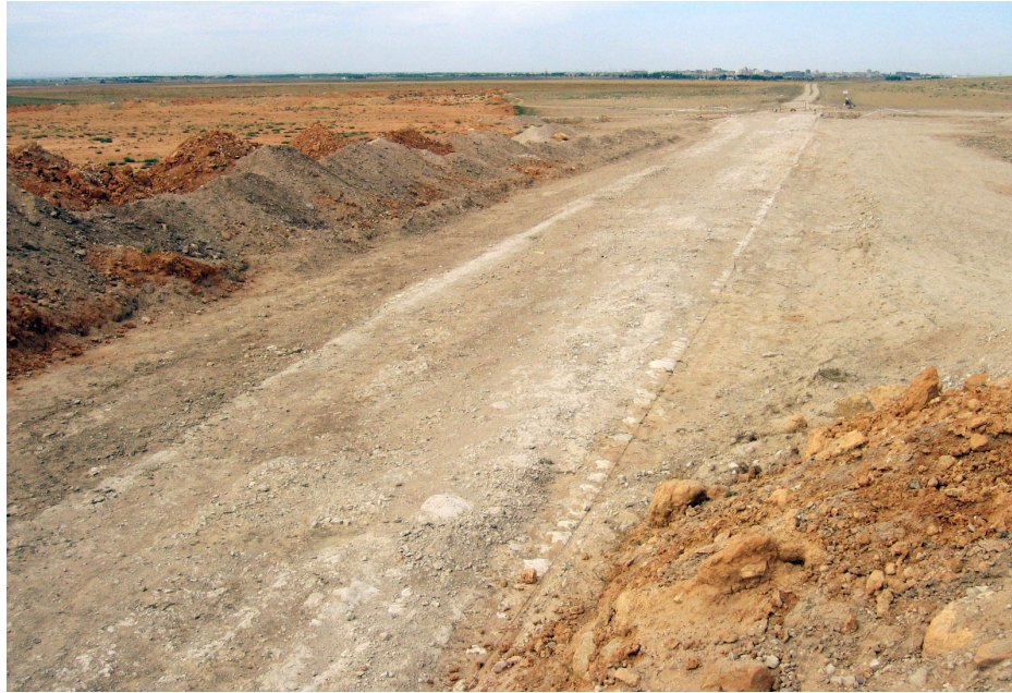
Vía romana de Cartagena a Segóbriga decapada hasta destruir todas las capas superiores del firme. La afección por una nueva urbanización en Chinchilla, Albacete, provocó las excavaciones arqueológicas para su estudio en 2006.
