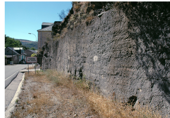
Pared de roca esquistosa tallada con buena geometría y mostrando los típicos golpes de pico romanos. Desmonte en roca de la vía romana, aprovechado por Carlos Lemaury para el paso de su carretera, en 1768.
