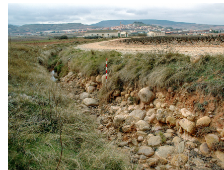
La vía romana seccionada longitudinalmente en Navarrete, cerca de donde se desmontó la carretera N-120 por donde continuaba.
