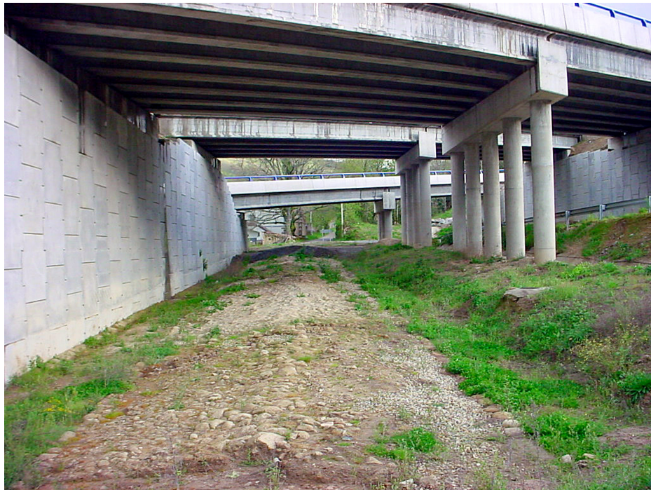
El Camino Real de Castilla superando el puerto de Béjar. El empedrado bien conservado de este camino de mulas con mucha pendiente, fue limpiado de la tierra vegetal que le cubría antes de decidir construir el viaducto que le salva del paso de la nueva autovía de la Plata.
