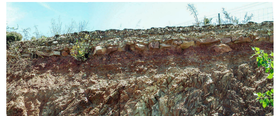
Pavimento «a la romana», con gruesas piedras en la cimentación y piedra más menuda sobre ella, procedente de la primitiva construcción de esta carretera a finales del siglo XVIII, en un corte de la antigua carretera N-II en el Frasno (Zaragoza). En la parte superior se aprecia también otro bien diferenciado de macadam, con doble tratamiento superficial como última capa de rodadura.
