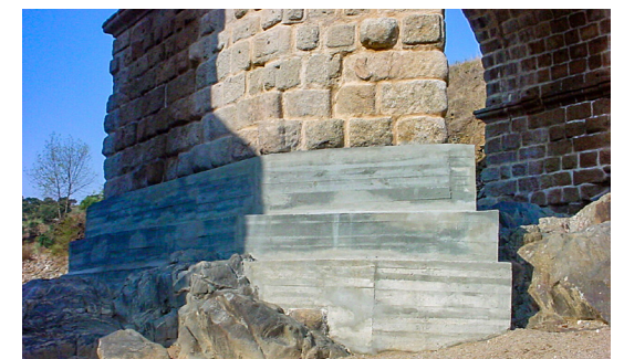
Aspecto final de una de las pilas, desfigurada para siempre en su estilo constructivo romano.
