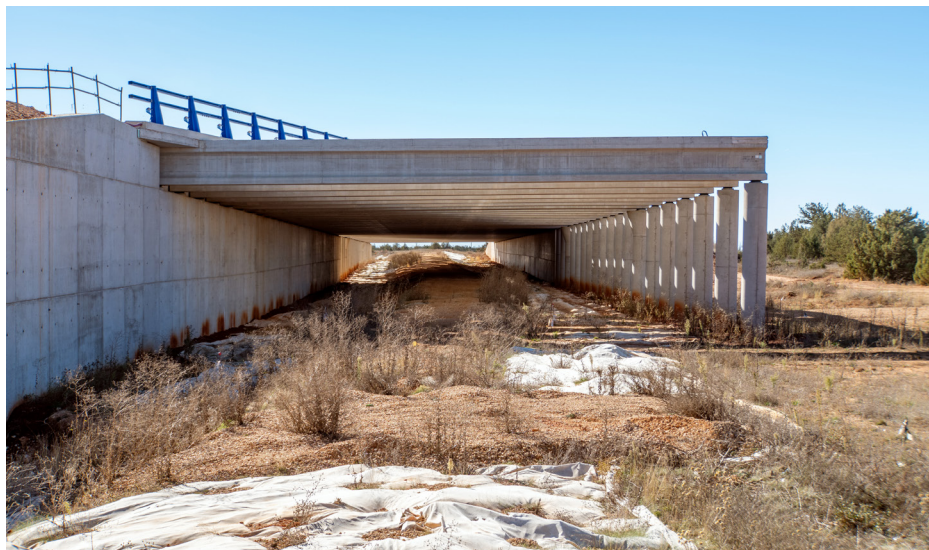
Aspecto general de una de las dos pérgolas ya construidas con la vía romana discurrendo bajo ella, protegida con geotextil y una buena capa de zahorras para evitar los posibles daños que podría producir la maquinaria pesada que construyó la pérgola.
