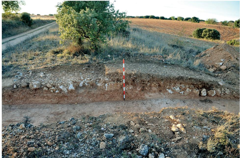
Los firmes que le suceden, diseñados ya para ser rematados en superficie con mezcla asfáltica, se apoyan de nuevo en mezclas de materiales sueltos, como los anteriores al macadam y como los romanos, siendo lo normal que confíen la mayor parte de su resistencia a un grueso espesor de zahorras naturales, o materiales similares, obtenidos directamente de cantera.
