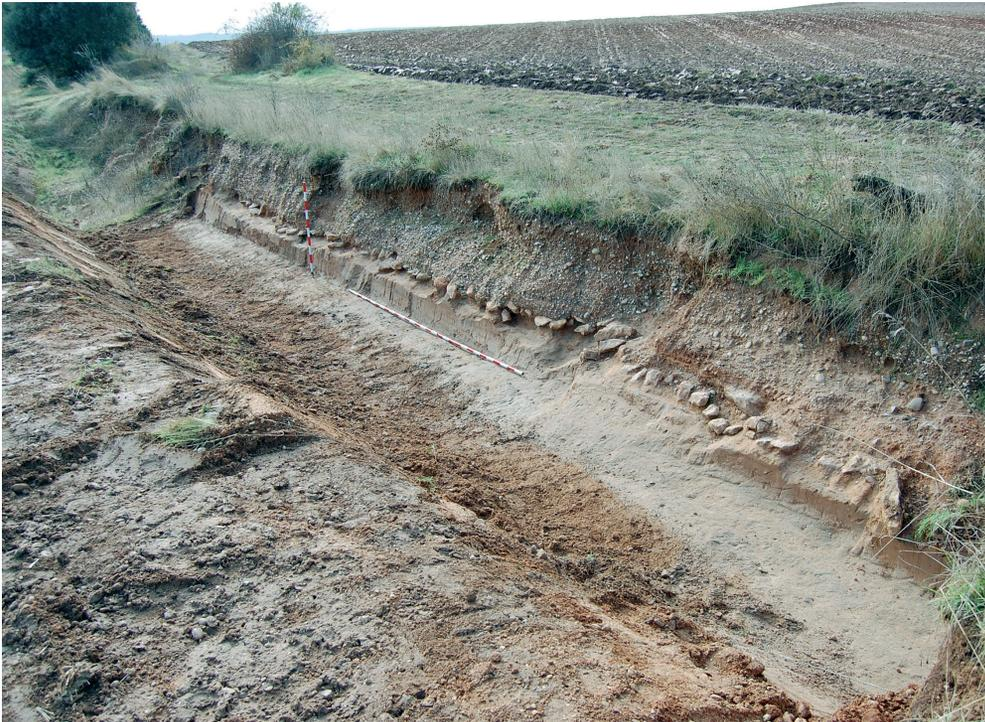
Paquete uniforme de zahorras naturales de 90 cm de espesor con cimentación de piedra gruesa y sobre terreno natural arcilloso. Limpieza de una sección longitudinal preexistente por la rotura del camino por un drenaje de fincas, en la Carretera de los Moros de Alcuilla de Avellaneda (Soria).
