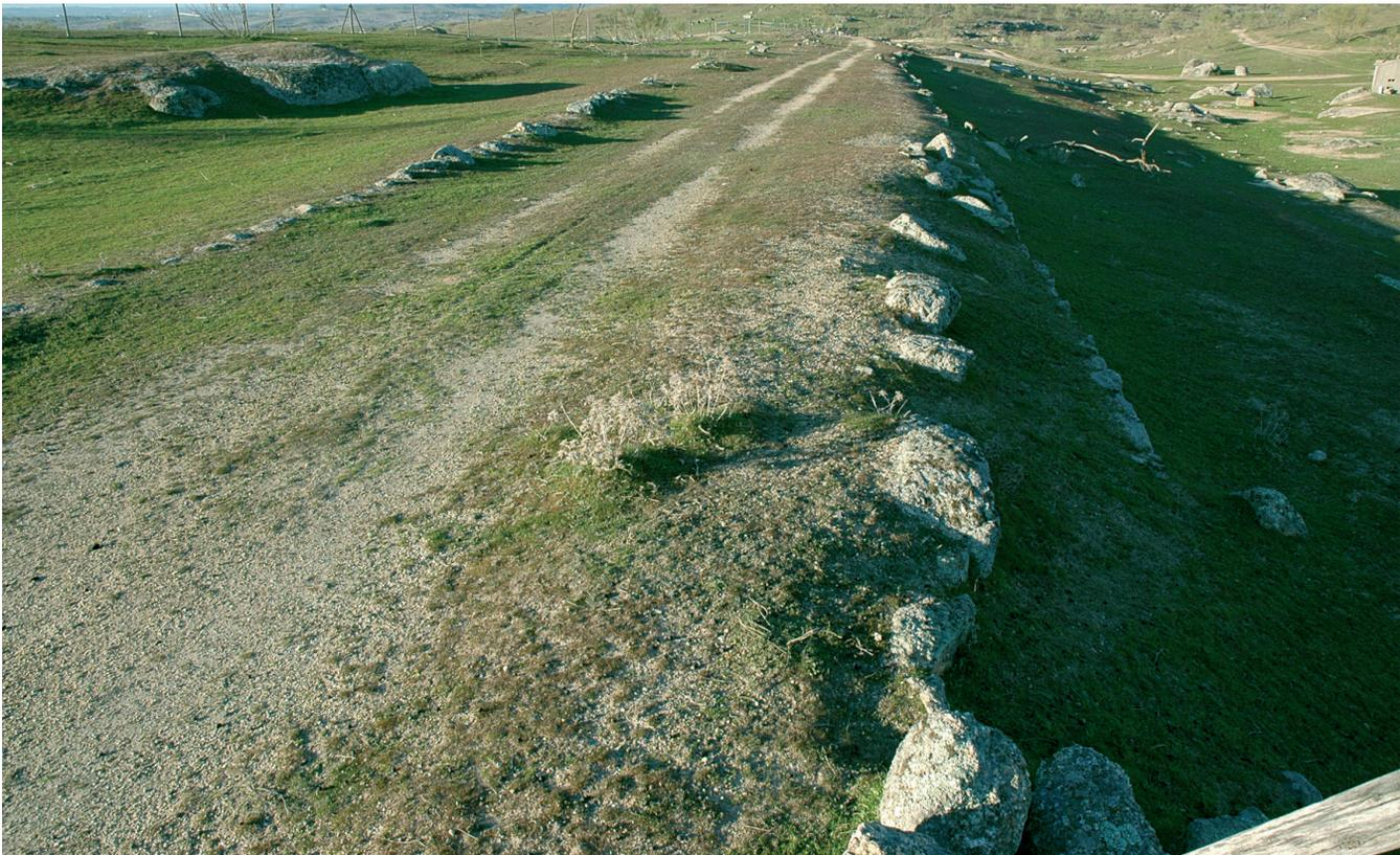
Bordillos de granito de la vía de la Plata formando un auténtico terraplén embordillado. Garrovillas de Alconetar (Cáceres).
