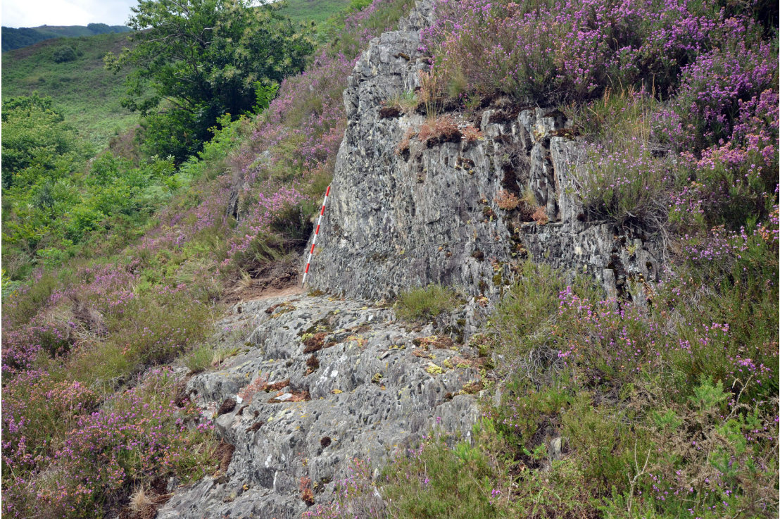
Figure 29, Uno de los muchos entalles, realizados a golpe de pico, para el paso de la vía romana en Valcarlos
