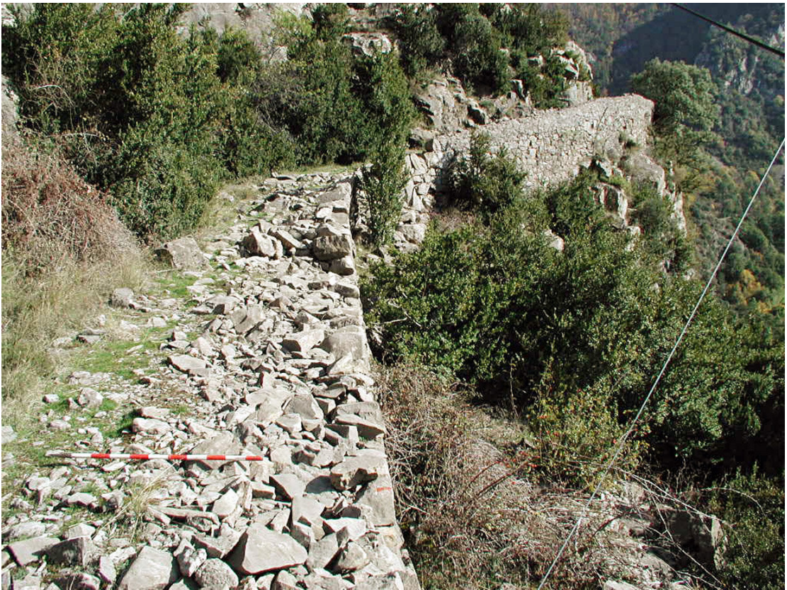
Figure 26, Aspecto del camino del Puerto del Palo en el único sitio que presenta alguna estructura constructiva de interés. Se trata de un muro de contención de mala factura, para sostener un camino de dos metros de ancho. Cuellos de Lenito en el Valle de Echo
