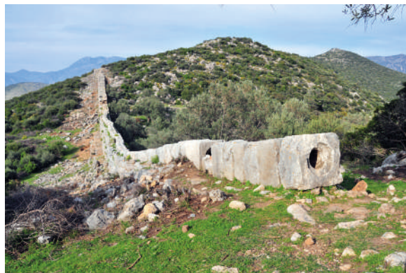
Fig. 11. Panorámica del gran sifón de Patara (Turquía) con tubería de piedra.
