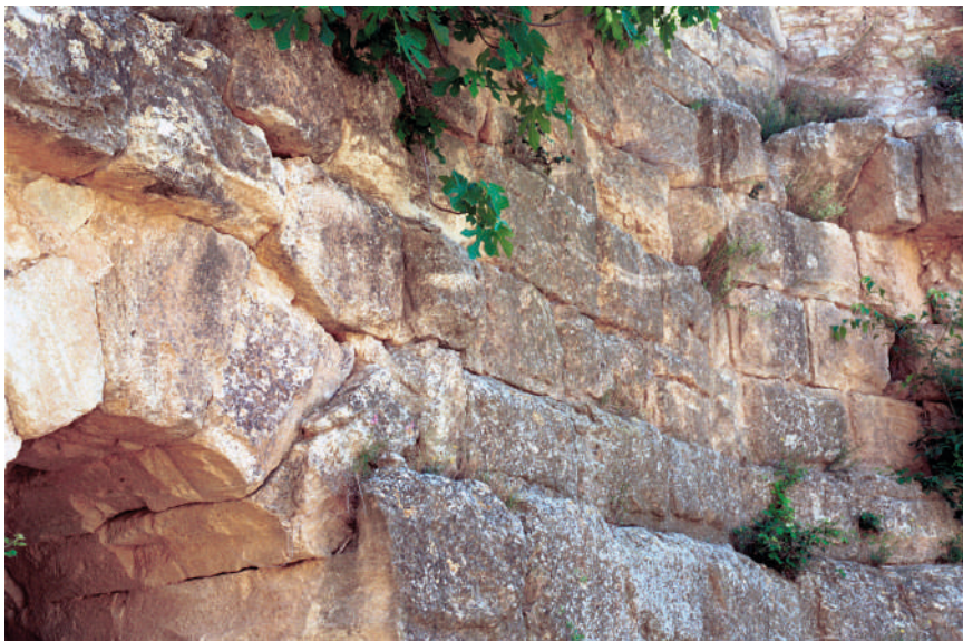
Fig. 35. Parte de la fábrica del aliviadero, en el paramento de aguas abajo. Vestigio de la presa más antigua, con clara tipología de fábrica romana. El almohadillado y el encaje de los sillares, se corresponden con el modo constructivo romano. La parte de la bóveda del arco (el ojo de la cuba) es una reconstrucción posterior.
