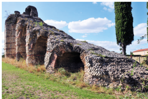
Figs. 12/13. Enorme rampa de bajada de los nueve tubos de uno de los sifones del acueducto del Gier, en Chaponost.
