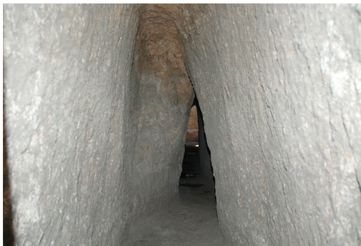
Fig. 32. Rectificación de trazado en una de las galerías subterráneas del acueducto de Uxama (Burgo de Osmá, Soria). La sección, uniformemente excavada hasta este punto, es desviada a la derecha para encontrarse con un tramo que empezó a excavarse desde la dirección contraria.
