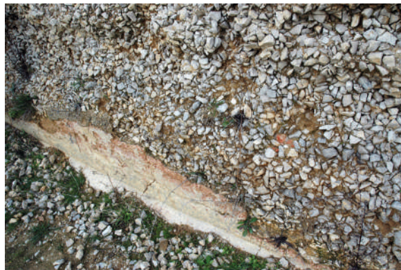
Fig. 51. Detalle del opus signinum , revistiendo las tongadas de hormigón de áridos de calidad, pertenecientes a una cisterna antigua e integrados en la balsa próxima a Andelo .
