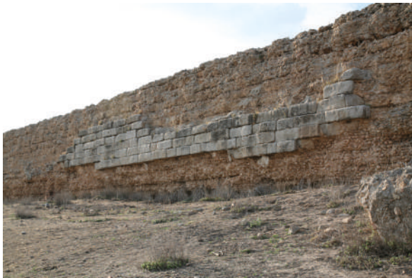
Fig. 45. Paramento de sillares regulares, bien dispuestos, pero rípidos con cantos menudos, formando el encofrado de las tongadas de hormigón de cal, en la presa de Alcantarilla. No es una fábrica del tipo romano y, además, contrasta con la irregularidad de los sillares de otras partes de la presa. Foto: C. Blázquez.
