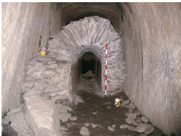
Fig. 10. Final de la excavación en terreno rocoso e inicio del revestimiento abovedado de la galería, que progresa en terrenos sueltos. Galería del acueducto del Gier, en la llamada Cave du Cure, en Chagnon (Francia).
