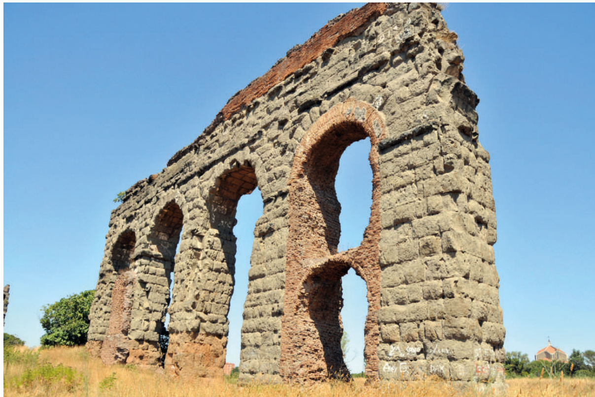
Fig. 9. Arquerías reforzadas con estructura interior de ladrillo, en el acueducto del Aqua Claudia , sobre el que se canalizó el Anio Novus posteriormente.
