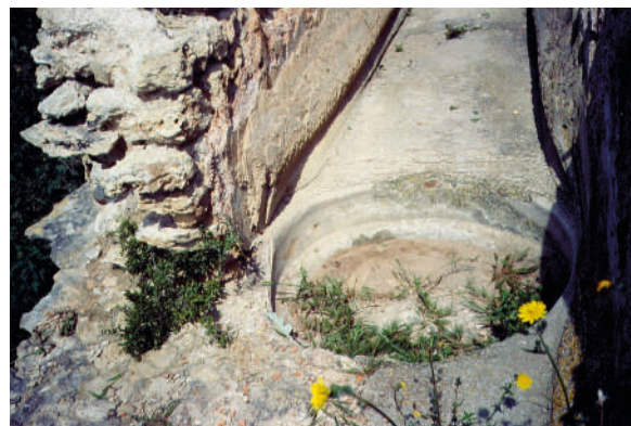
Fig. 15. Arenero en pozo de registro del acueducto de Cartago (Túnez). Foto: J. C. Litaudon.
