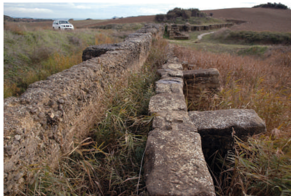
Fig. 53. Presa con doble muro a tres kilómetros al occidente de Andelo . Uno formado de hormigón de cantos gruesos y el otro de sillería irregular con contrafuertes.
