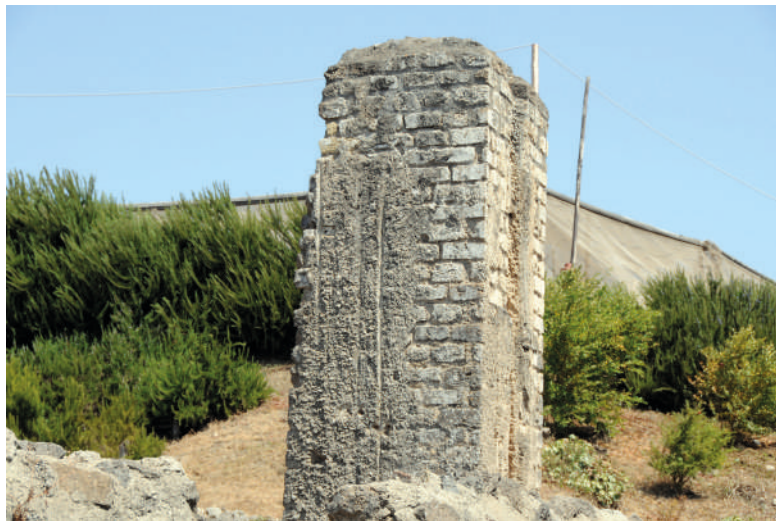
Fig. 26. Huella de las tuberías formadas sobre la propia concreción calcárea procedente del chorreo. Columna de sustentación de un depósito secundario en Pompeya.
