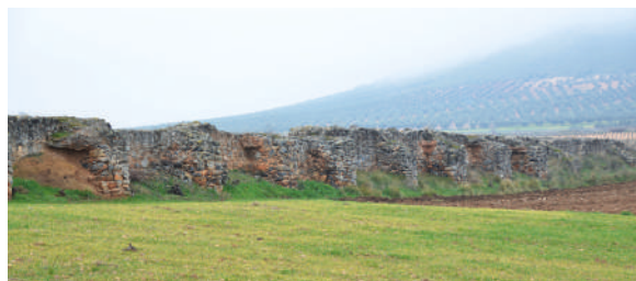
Fig. 49. Presa de Consuegra, formada de un hormigón de tamaños grandes y pobre en cal. Tramo con contrafuertes.
