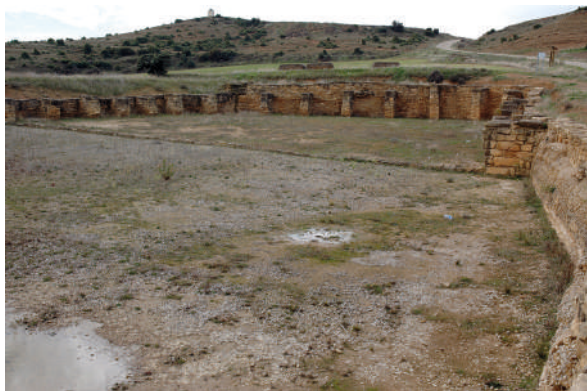
Fig. 50. Cisterna romana de hormigón próxima a la ciudad de Andelo , ampliada probablemente como abrevadero, con una pared de contrafuertes de mala factura, en épocas más recientes.
