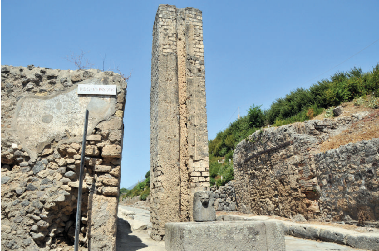
Fig. 25. Pilar de sustentación de un depósito elevado de distribución secundaria en Pompeya. El sobrante de caudal era aprovechado para abastecer una de las muchas fuentes de la ciudad.
