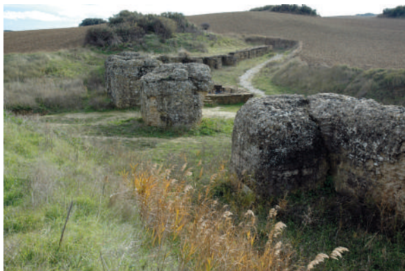
Fig. 52. Muro de hormigón con grandes contrafuertes, en la presa situada a tres kilómetros al occidente de Andelo . En el paramento de aguas arriba se construyó un muro de sillería irregular separado por arcilla del primero.
