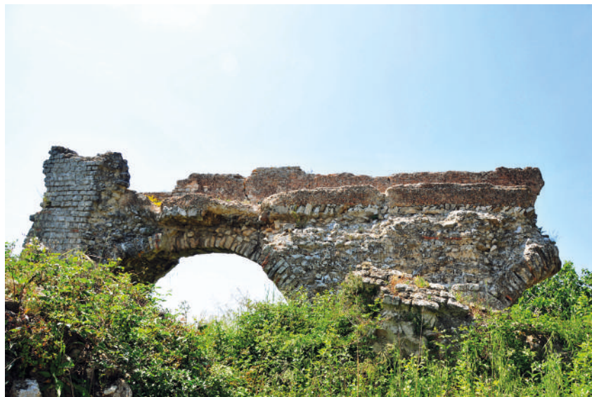
Fig. 7. Revestimiento de gran espesor de mortero impermeabilizante ( opus signinum ), en el cajero situado sobre las arquerías del acueducto de Barbegal en Arles (Francia).
