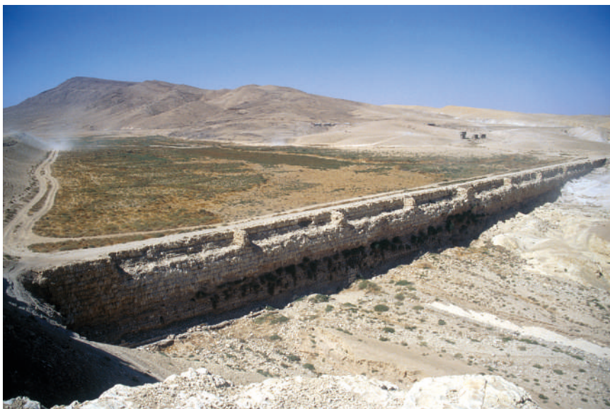
Fig. 42. Vista general de la presa de Harbaqa (Siria). Foto: M. Durán.
