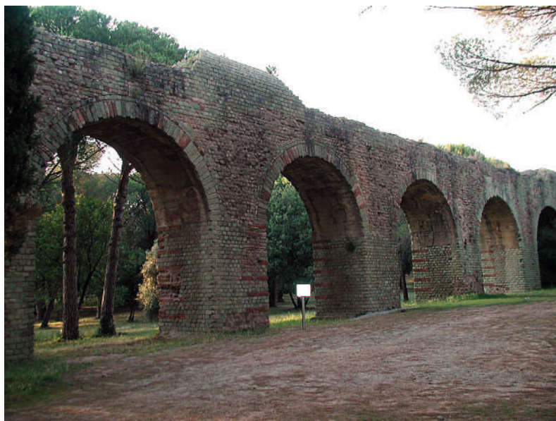
Fig. 6. Tramo de canal, aún abovedado, conservado sobre las arquerías del acueducto de Forum Iulii (Frèjus, Francia).
