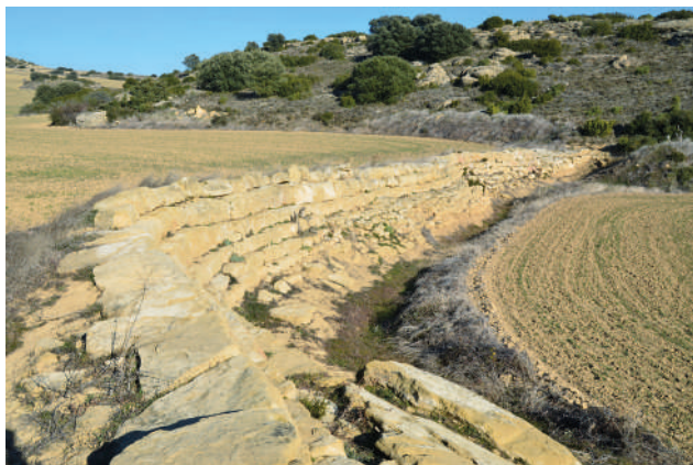
Fig. 54. Muro de contención que se hace pasar por presa romana en Los Bañales (Uncastillo-Zaragoza), a pesar de estar constituido por bloques irregulares, más pequeños en los niveles inferiores y apoyados en el terreno en hiladas sin ningún tipo de nivelación.
