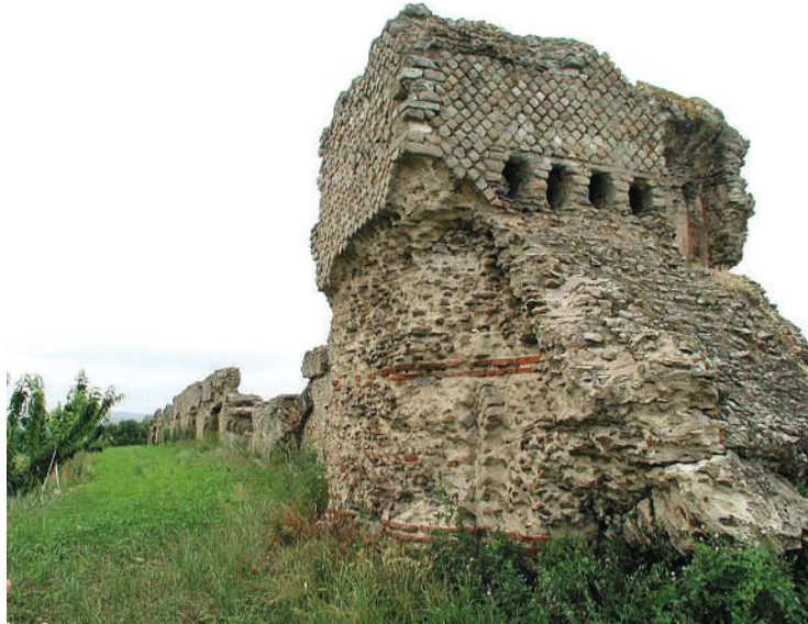
Fig. 3. Cámara de entrada del sifón de Soucieu-en-Jarrest en el lugar de la Gerle, en el acueducto del Gier, con los orificios de las tuberías de plomo que lo constituían y la rampa de apoyo.
