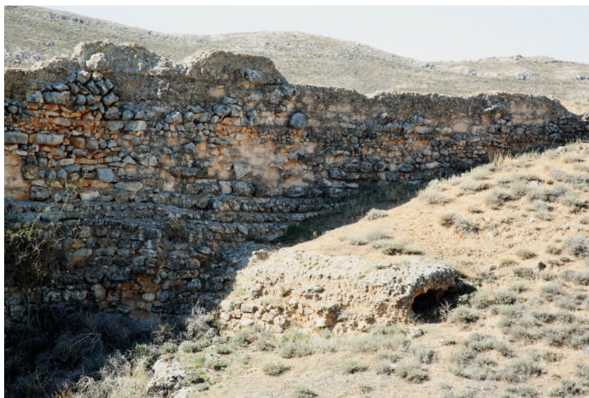
Fig. 47. Vista de la pobre fábrica, mal escuadrada y mal nivelada, de la presa llamada Pared de los Moros, en Muniesa (Teruel). Foto: C. Blázquez.
