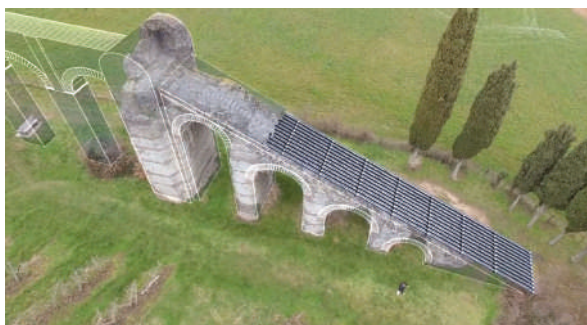
Figs. 12/13. Enorme rampa de bajada de los nueve tubos de uno de los sifones del acueducto del Gier, en Chaponost.
