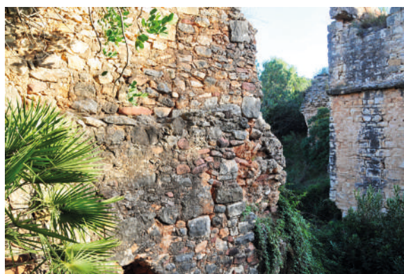
Fig. 60. Detalle de la fábrica del acueducto de Ribarroja. En pie, en buena parte, a pesar del deficiente aparejo que se observa.
