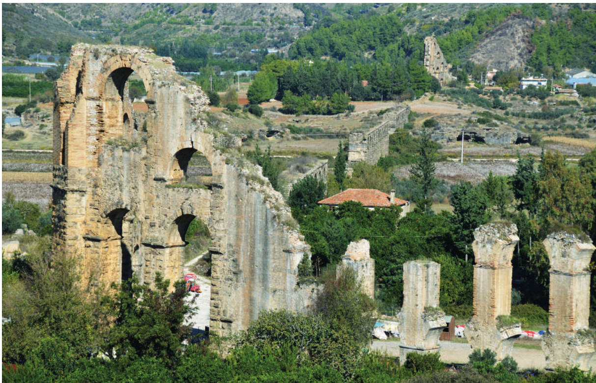
Fig. 4. Torres de descarga de presión en los cambios de alineación del acueducto de Aspendos.
