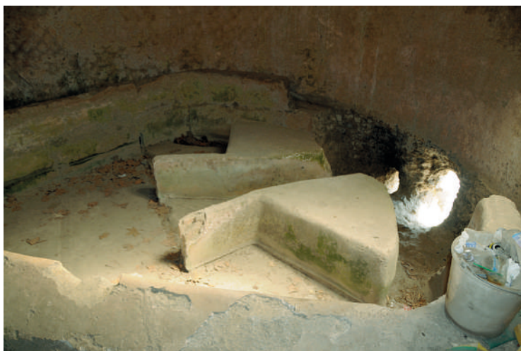
Fig. 20. Cámara de distribución del castellum divisorium de Pompeya. El partidor distribuye el agua para los tres usos descritos por Vitruvio fijando una altura de alivio para cada uno de ellos.
