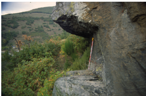
Fig. 17. Voladizo en semitúnel que limita el paso del agua. Canal C-3 en las inmediaciones de la Virgen del Valle (Llamas de Cabrera-León).
