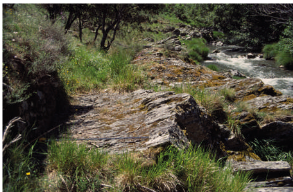
Fig. 8. Canal C-1 de Las Médulas. Captación del río Cabrera en las proximidades de Encinedo (León).
