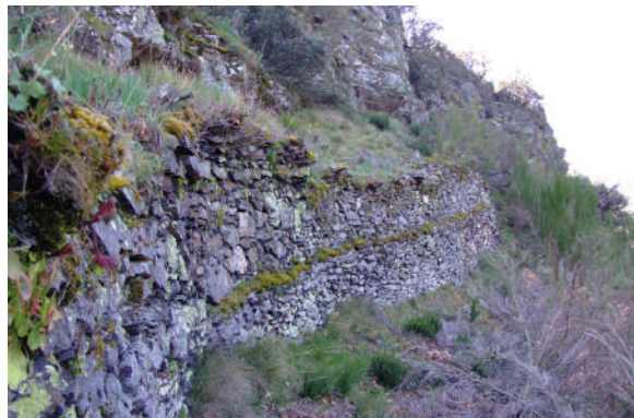
Fig. 35. Muros de sostenimiento del canal C-1 en la Virgen del Valle (Llamas de Cabrera, León).
