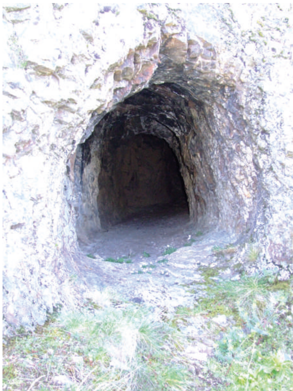
Fig. 36. Entrada al túnel TC-1.1.1. Canal C-1 en la Virgen del Valle (Llamas de Cabrera, León).
