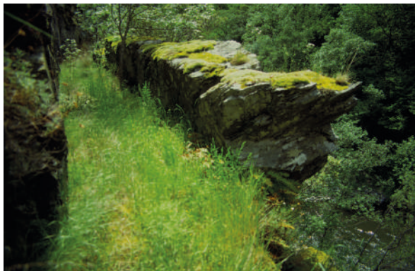
Fig. 34. Canal C-0 en las inmediaciones de su captación (Odollo, León).
