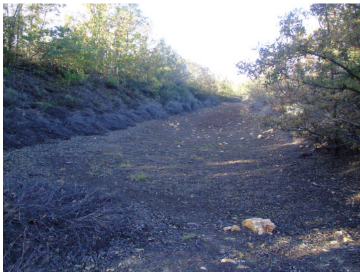
Fig. 32. Depósito de regulación-distribución de La Fucarona (Rabanal del Camino, León).
