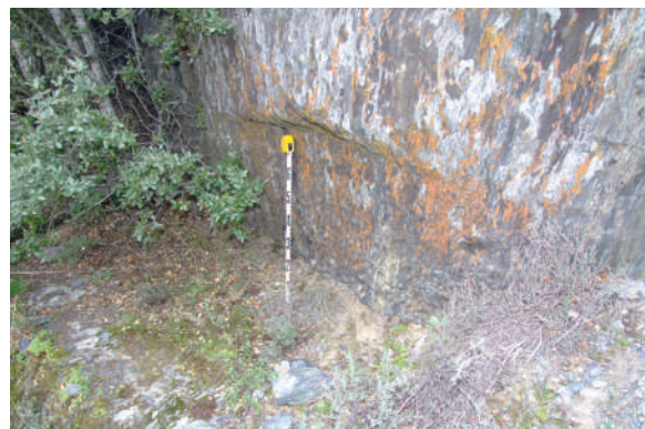
Fig. 18. Excavación en voladizo. Canal C-3 en Saceda (León).
