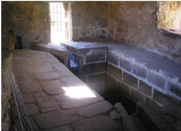
Fig. 13. Desviación de canales en la Casa de Aguas del acueducto de Segovia.
