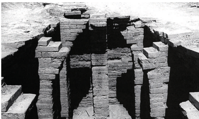
Fig. 13. Cisterna del palacio de Mari del II milenio A.E.C. (Viollet 2000).
