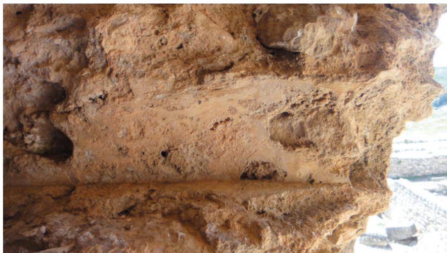
Fig. 13. Detalle del supuesto specus . Ausencia de ángulos abocelados y otras estructuras hidráulicas. Fotografía del autor.
