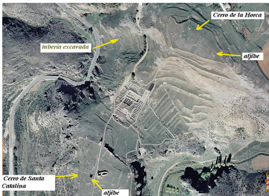
Fig. 25. Ubicación de aljibes sobre cota de los decantadores del foro y ubicación de la excavación en el Hoyo occidental del conducto por tubería que asciende hacia el área foral.
