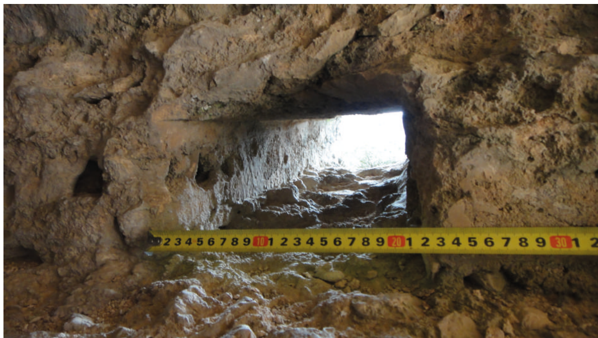
Fig. 15. Mechinal transfixivo: dimensión horizontal. Huella de los elementos de madera. Ausencia de vestigios hidráulicos. Fotografía del autor.
