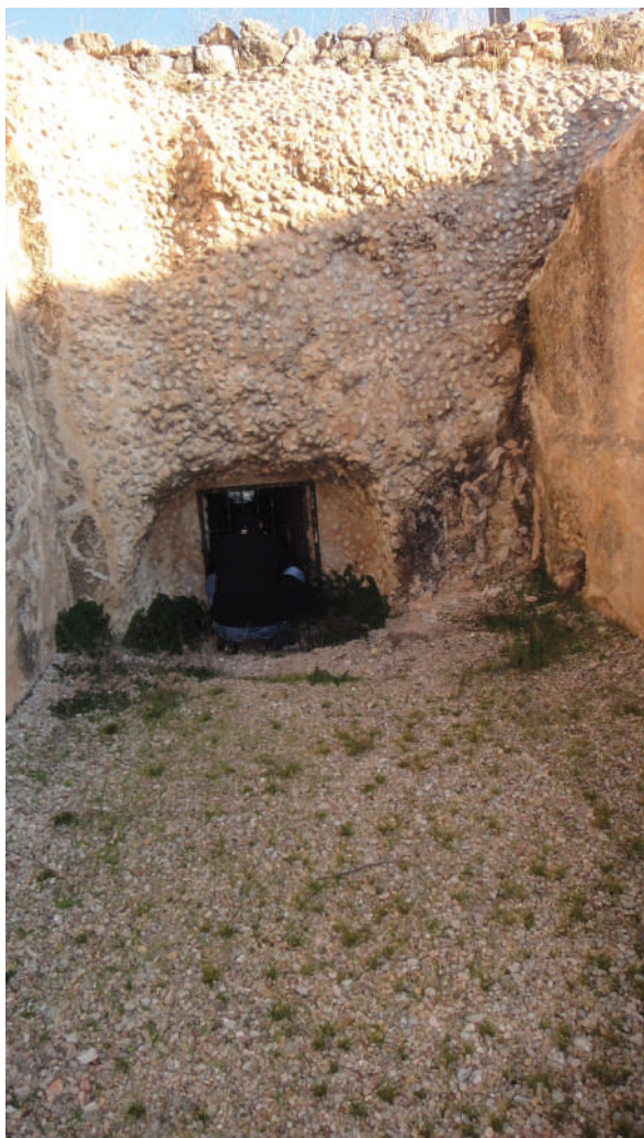
Fig. 9. Boca de la atarjea de desagüe, decantador nº 4, pared E. Fotografía del autor.
