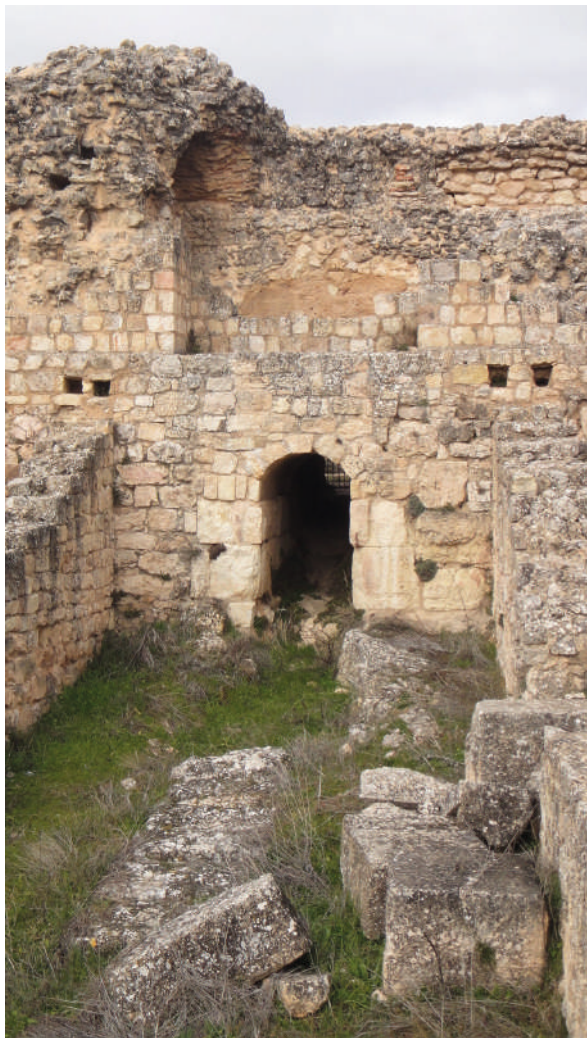
Fig. 18. Salida de la atarjea por la taberna 4, tras cruzar bajo el muro abovedado y la fachada del ninfeo. Fotografía del autor.
