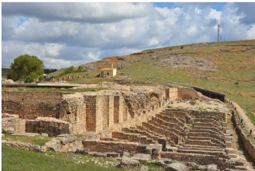
Fig. 3. Sistema de contención del foro por el E. Línea de fachada de exedras y nichos y batería de tabernae abiertas al cardo. A la izquierda, en alto, cubrimiento de cemento de los aljibes del foro. Fotografía del autor.
