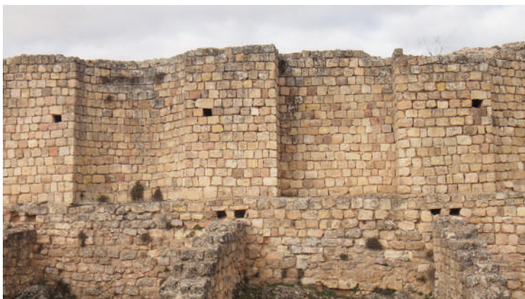
Fig. 17. Mechinales transfixivos en cota del specus sobreelevado y no transfixivos en cota inferior. Fotografía del autor.
