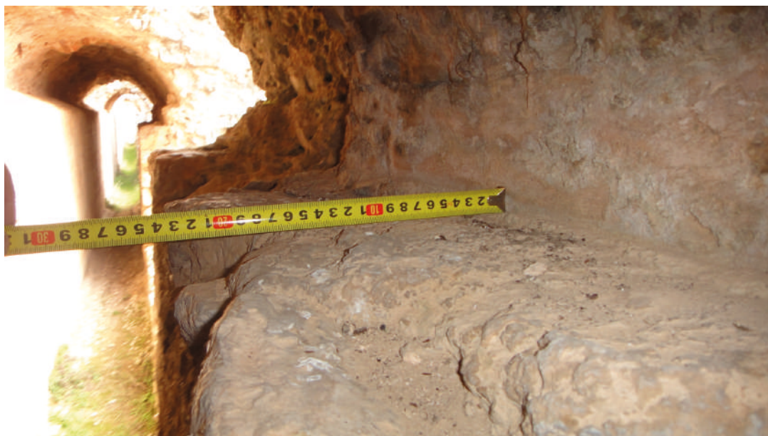
Fig. 12. Anchura de la plataforma del resalte E, donde se describe un specus . Fotografía del autor.
