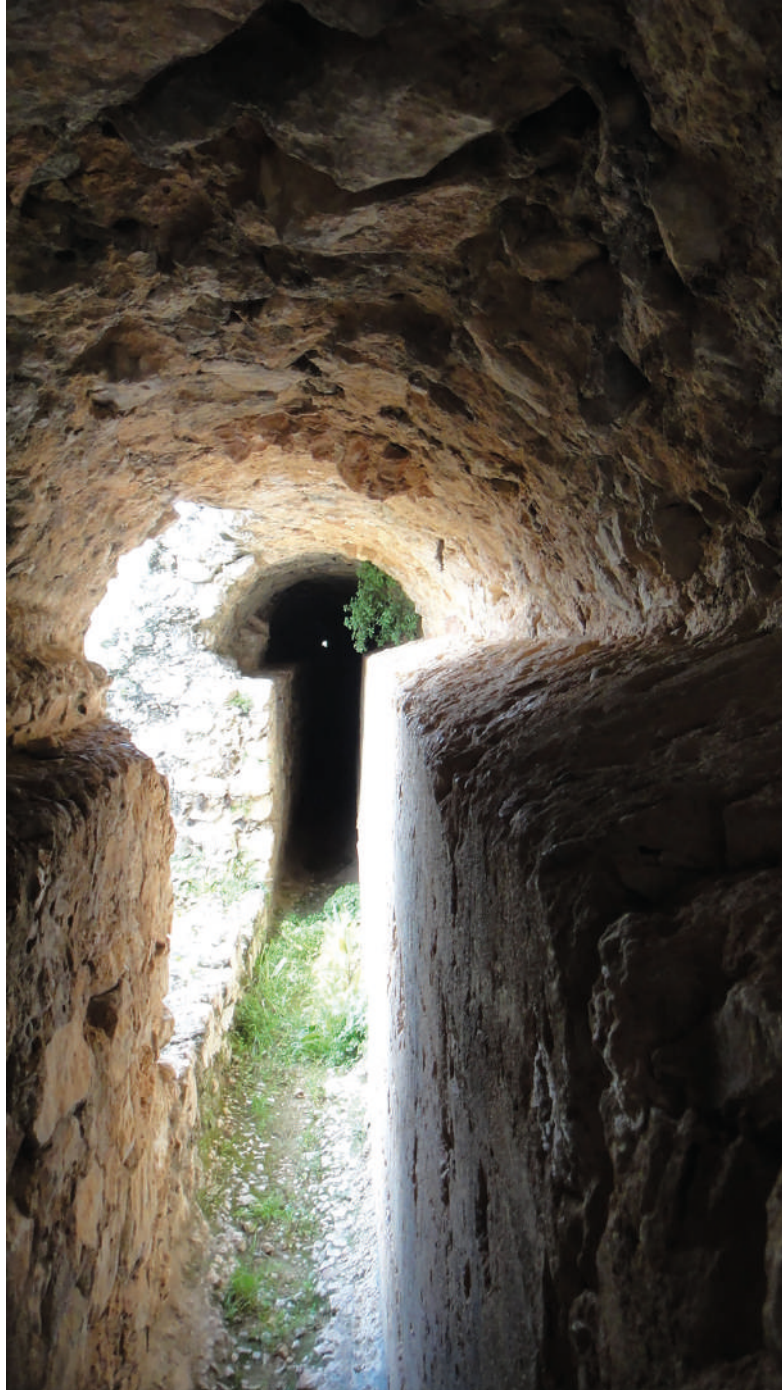
Fig. 4. Galería abovedada, detalle de los dos resaltes: a la derecha, muro O; a izquierda, el del E, donde se ha descrito un specum . El suelo de la galería es un canal de opus signinum abocelado, por donde Antonio Ponz (1789) caminó “de pie con todo desahogo”. Fotografía del autor.
