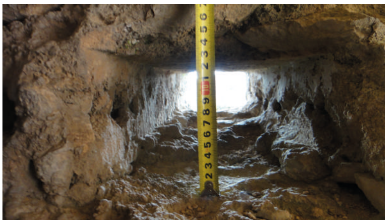
Fig. 16. Mechinal transfixivo: dimensión vertical. Fotografía del autor.
