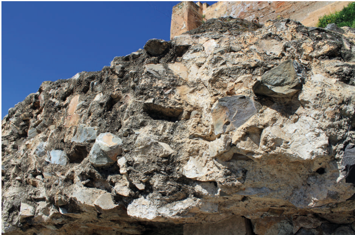
Fig. 11. Detalle constructivo del opus caementicium .
