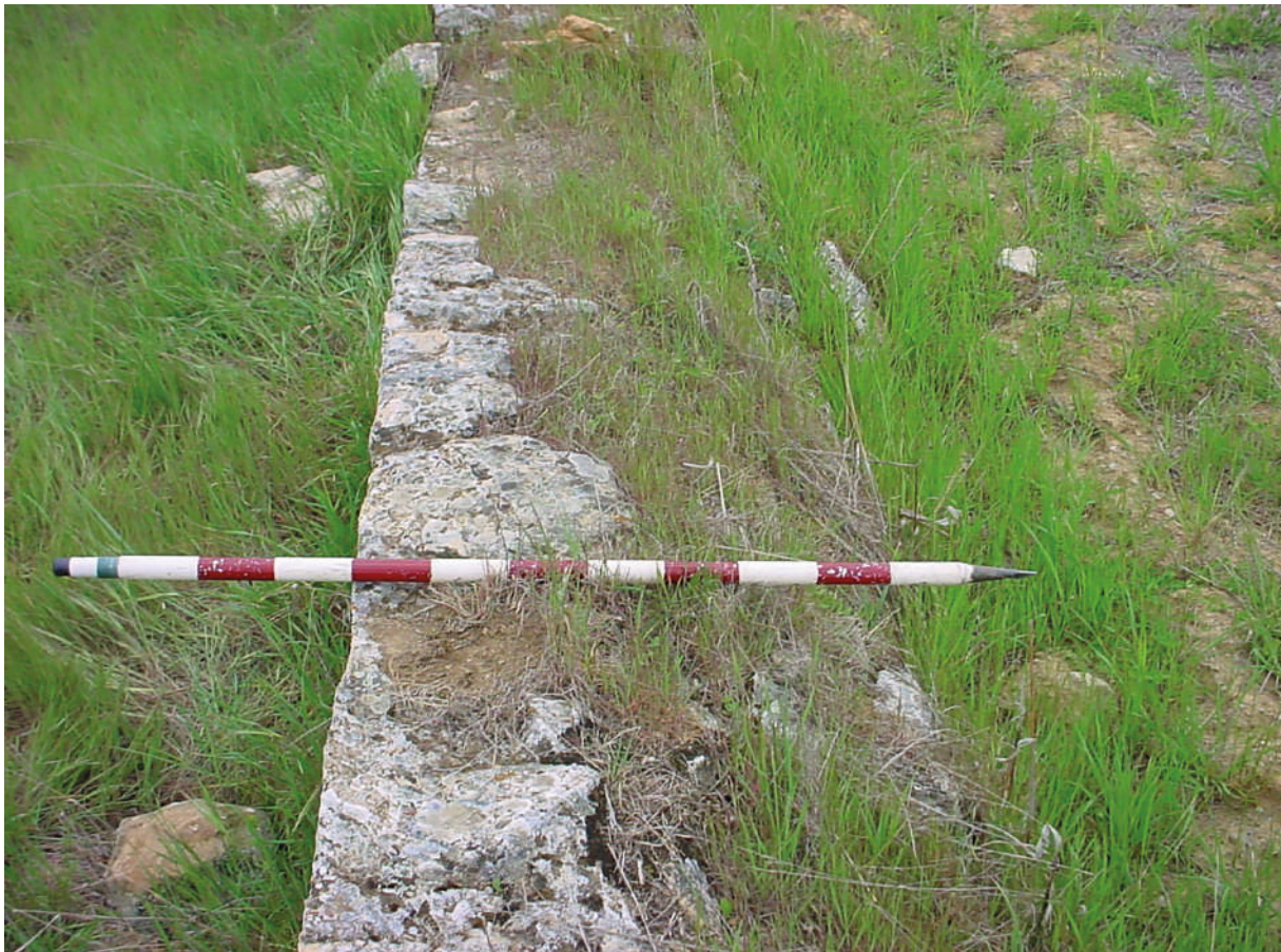
Fig. 17. El acueducto de Regina en una fotografía del año 2005.
