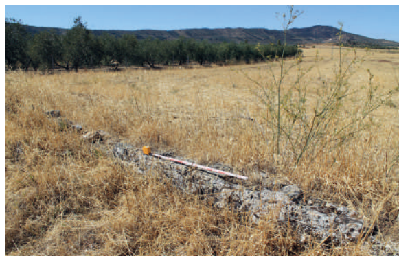
Fig. 15. Restos del acueducto romano de Regina construido con mampuestos calizos unidos con cal.
